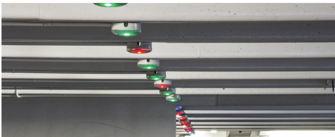
Joonis 4. Erinevate värvikoodidega LED laesensorid [1].
