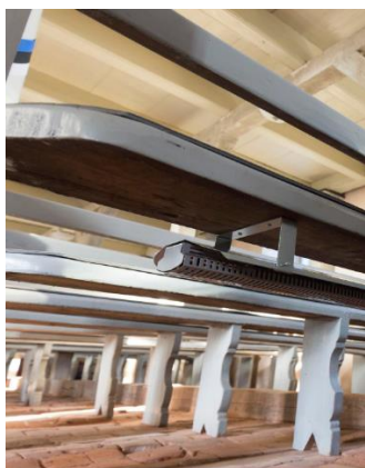
Joon. 7 Kõpu Peetri koguduses on pingialused elektrilised kiirgurid (vasak joonis), diislikütel põrandapealsed soojuskiirgurid, Kadrina kirikus, Lüganuse kirikus, Valga Peetri-Luke koguduses (keskmine joonis), elektrilised seinapealsed kiirgurid Kose Püha Nikolause koguduses (parem joonis)
