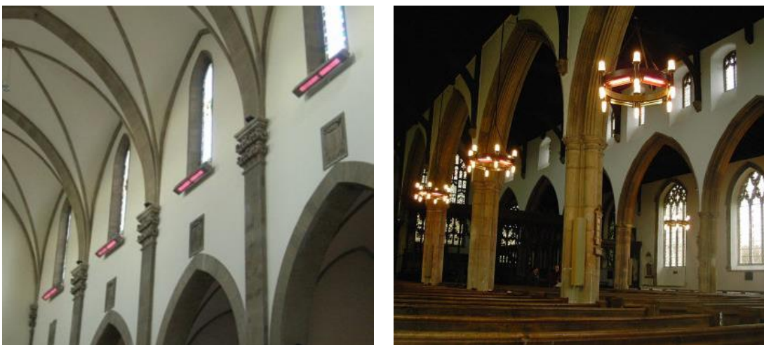
Joon. 5 Gaasikiirgurid Itaalia kirikus (vasak joonis) ja elektrilised kiirgurid St. Michaels kirikus Inglismaal (parem joonis)
