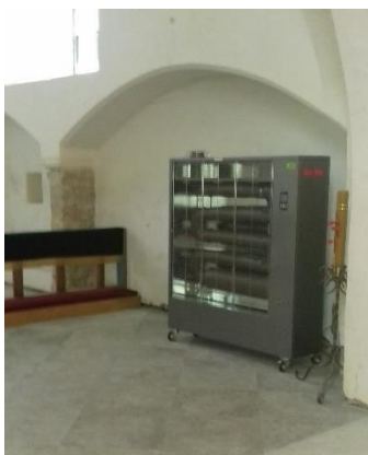
Joon. 7 Kõpu Peetri koguduses on pingialused elektrilised kiirgurid (vasak joonis), diislikütel põrandapealsed soojuskiirgurid, Kadrina kirikus, Lüganuse kirikus, Valga Peetri-Luke koguduses (keskmine joonis), elektrilised seinapealsed kiirgurid Kose Püha Nikolause koguduses (parem joonis)
