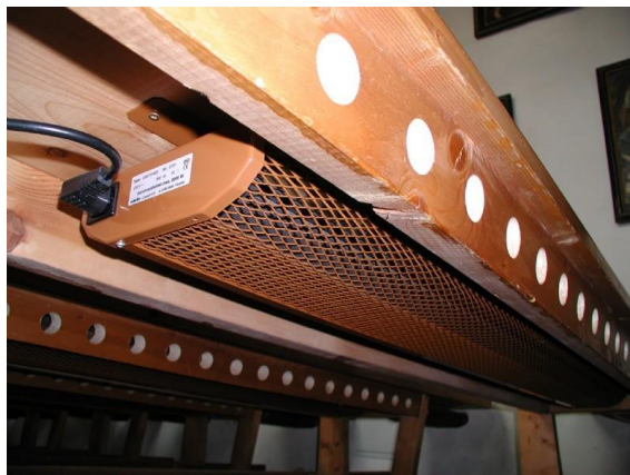
Joon. 6 Pingialune infrapuna soojendi, elektriline. Projekteeritud carlo Loysch Austria ettevõttega, mis tegeleb kirikute kütte lahendustega
