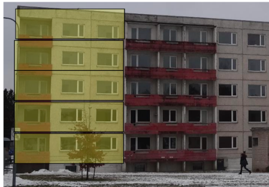
Joonis 2.4 paneelide asetus fassaadil. [38]
