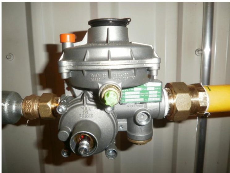
Sele 1.6 Gaasi rõhuregulaator
