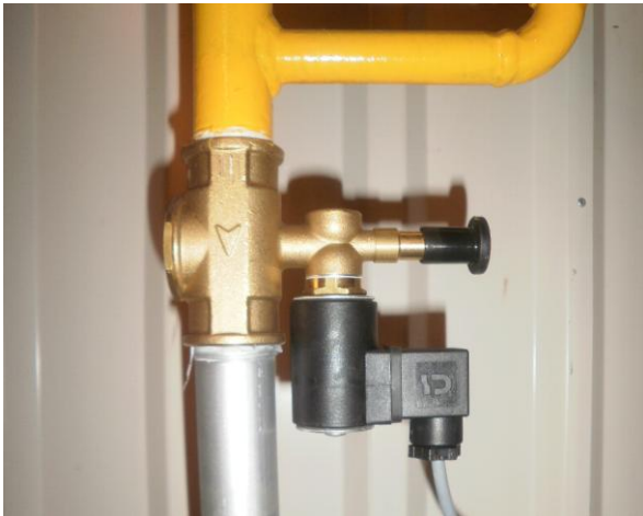
Sele 1.4 Solenoid magnetklapp ja gaasilekke seade
