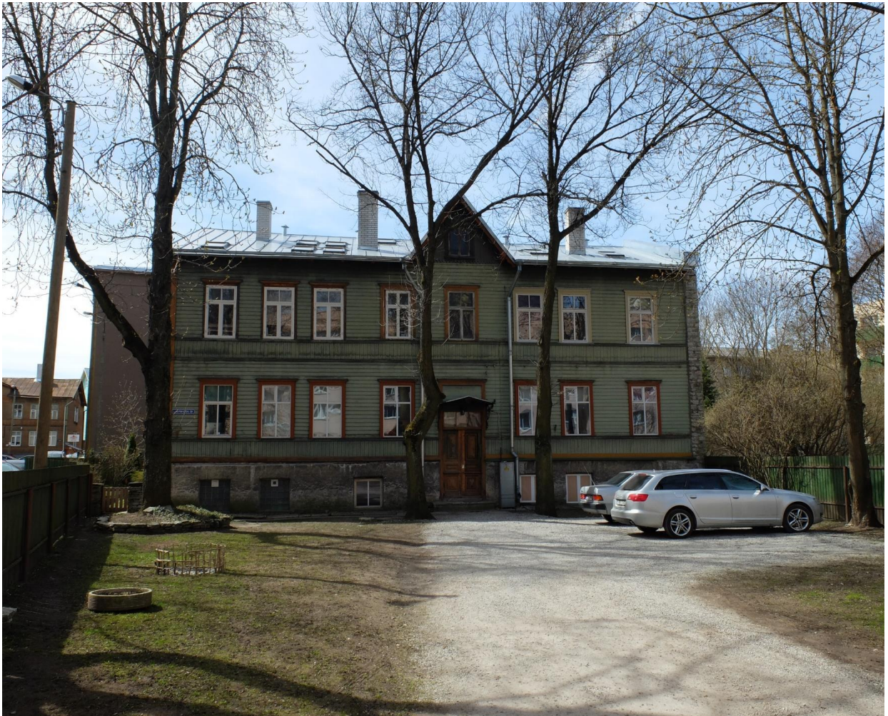
Joonis 4. Vaade Lastekodu 28 hoonele põhjast
