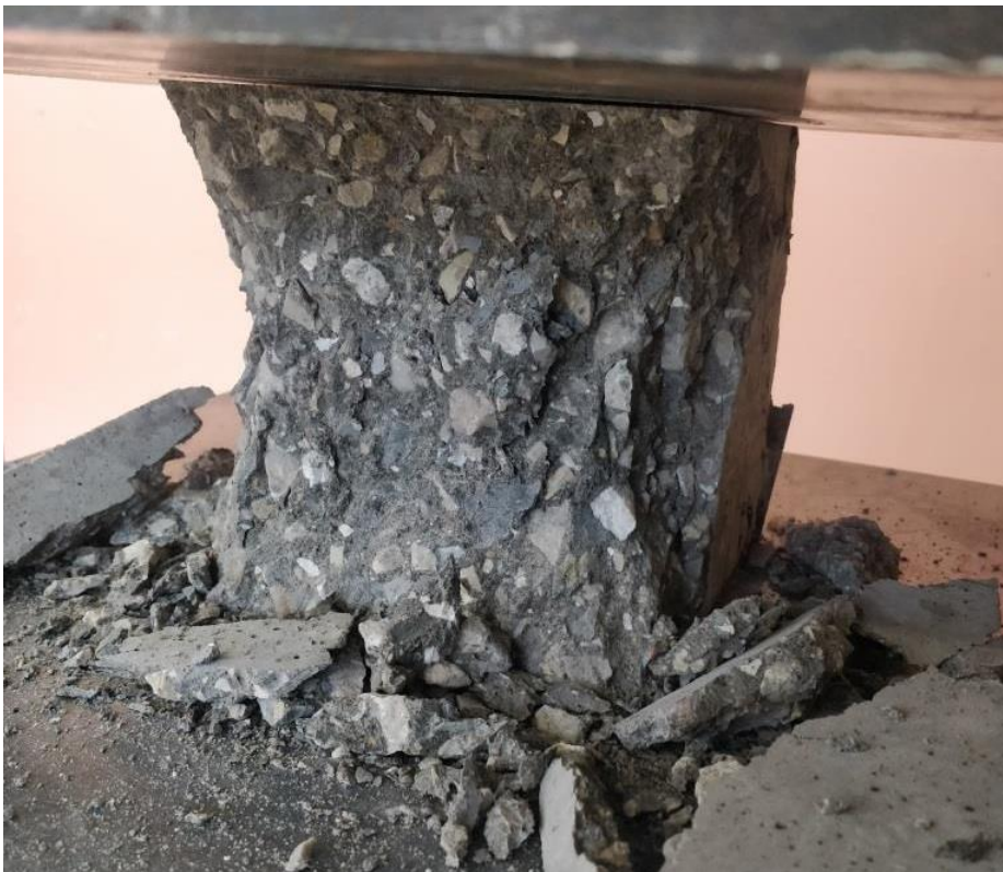
Joonis 3.4 Katsekeha T1-10 (betoon C25/30 XC2 lisandita) purunemispilt
