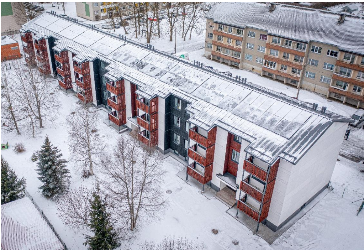
Pilt 9. Kuuma 4 renoveeritud kujul. Hoovipoolne vaade (Timbeco 2021)
