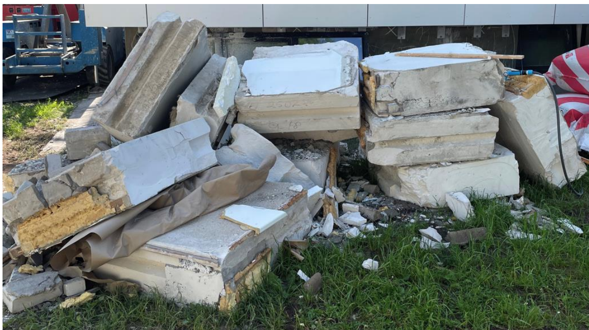
Pilt 13. Tekkinud betoonijäätmed hoone renoveerimisel (Kullerkupp 2021)
