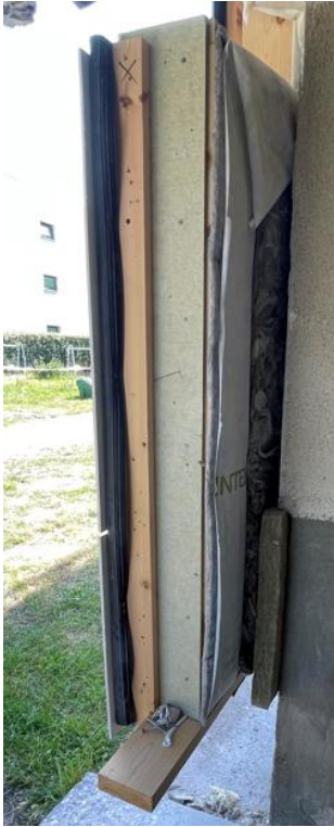
Pilt 5. Paigaldatud väliseinapaneel (Kullerkupp 2021)
