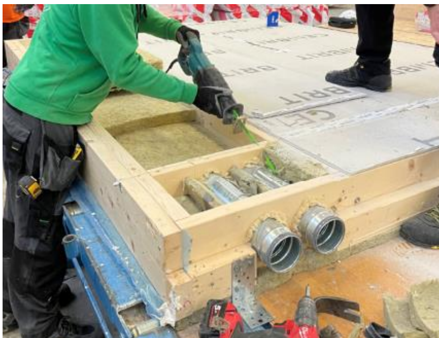
Pilt 22. Ventilatsioonitorustiku avamine
