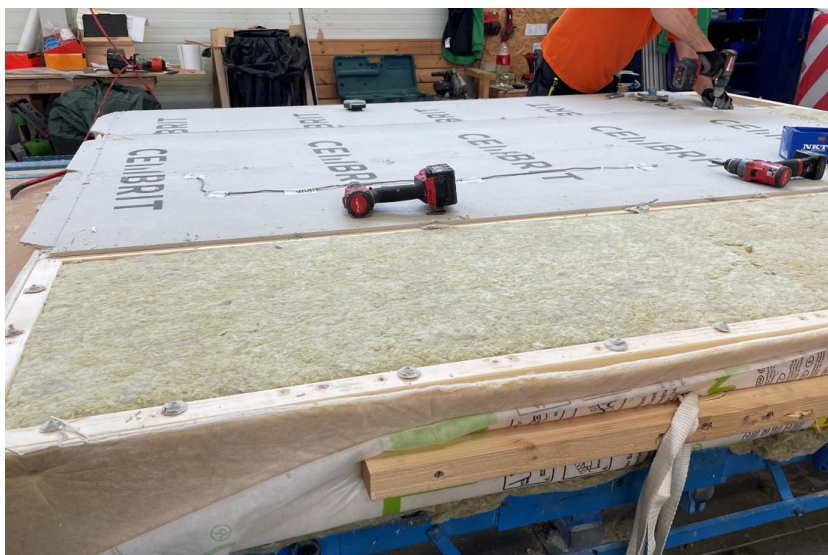
Pilt 17. Testseinapaneeli demontaaž (Kullerkupp 2021)
