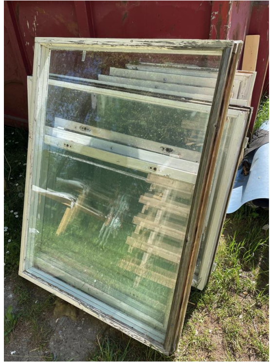
Pilt 12. Demonteeritud vana aken (Kullerkupp 2021)
