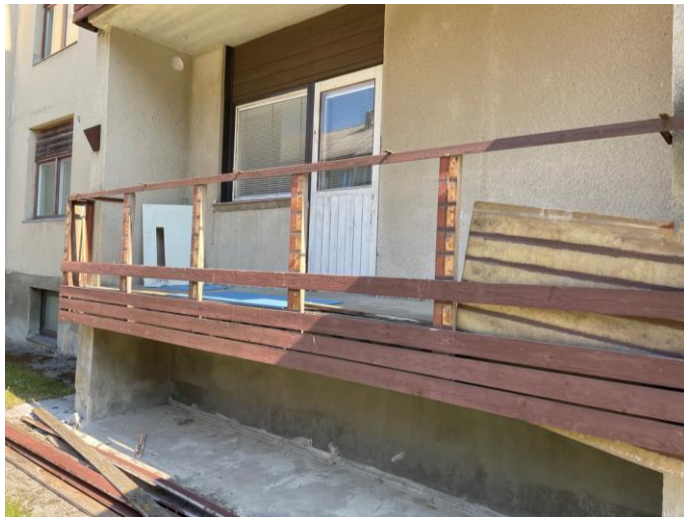
Pilt 10. Rõdupiiretelt ja akende kohalt eemaldatav puitmaterjal (Kullerkupp 2021)
