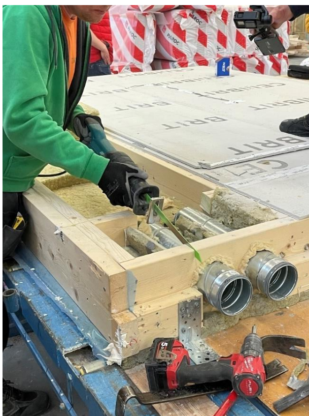
Pilt 18. Ventilatsioonitorustike kättesaamine (Kullerkupp 2021)
