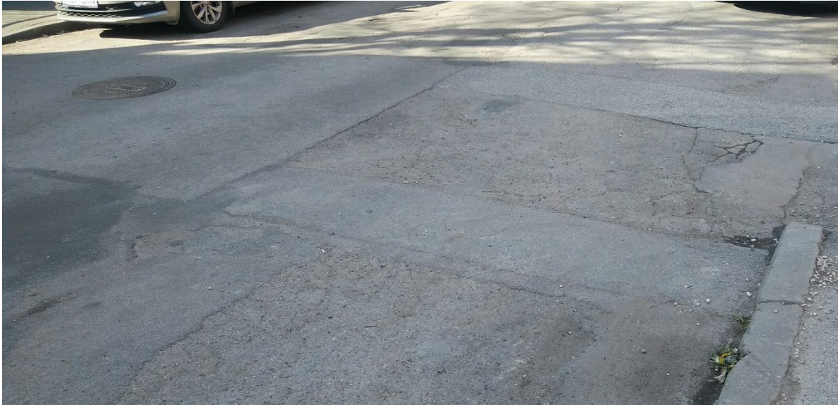
Joonis 1.1 Deformeerunud ning mitmeid kordi lapitud sõidutee
