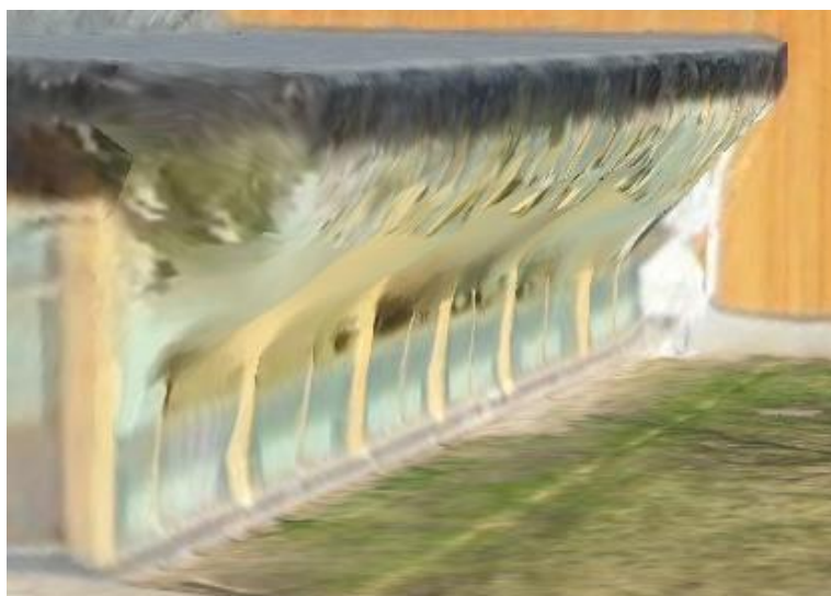
Joonis 3.2 C hoone deformeerunud klaasfassaad 50° mudelil. Autori foto
