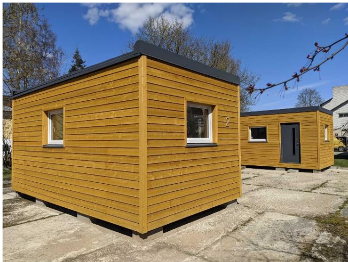
Joonis 2.9 Pilt TalTech Tartu kolledži ehituse labori katsemajadest. Autori foto
