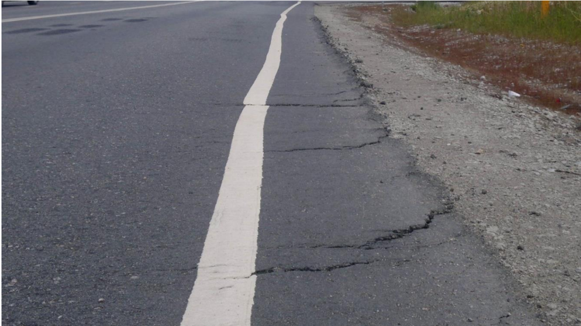
Joonis 4.1. Kulumiskihi nihkumisest tekkinud deformatsioonid [erakogu]
