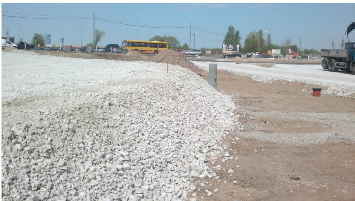
Joonis 2.1. Killustikmaterjaliga kaetud nõlv [erakogu]
