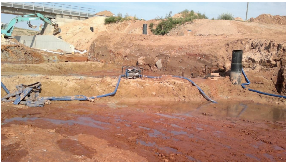
Joonis 1.1. Allikalises piirkonnas asuva teesüvendi hoidmine kogu ulatuses veevabana [erakogu]
