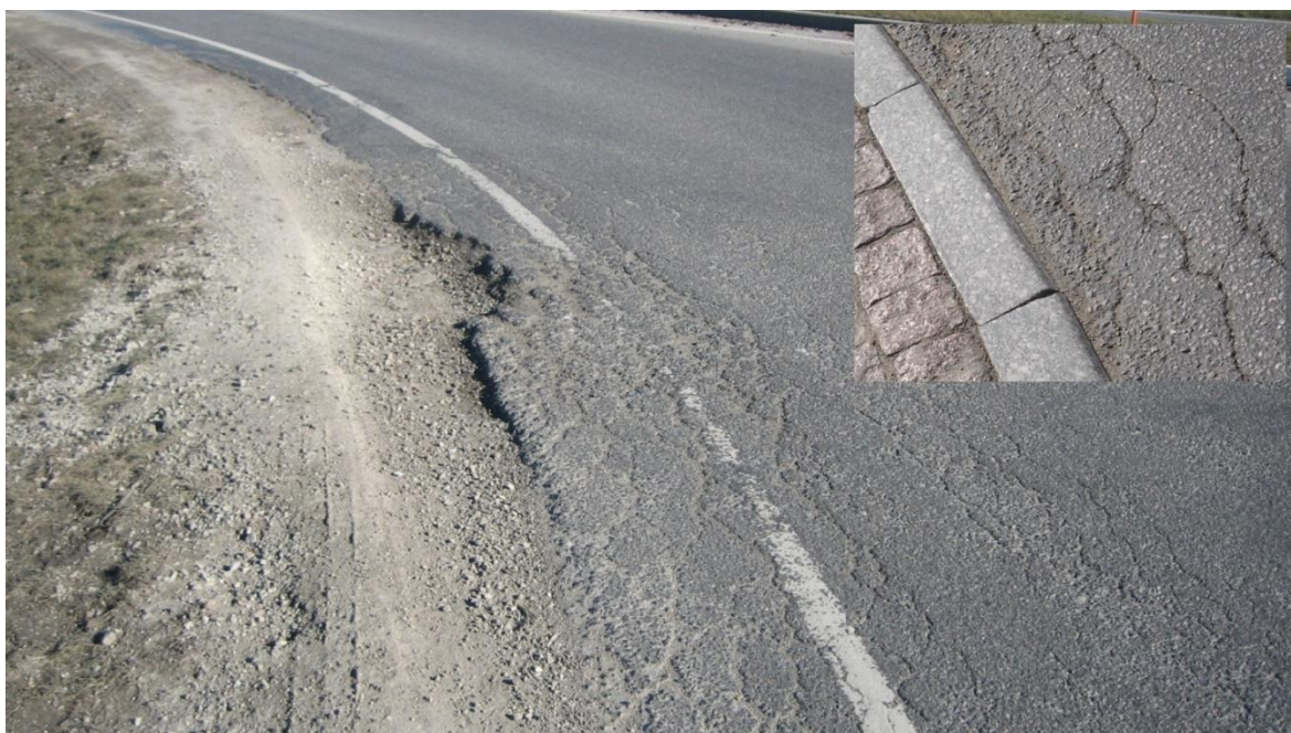
Joonis 4.10. Ringristmiku teekatte äärte kahjustused [erakogu]
