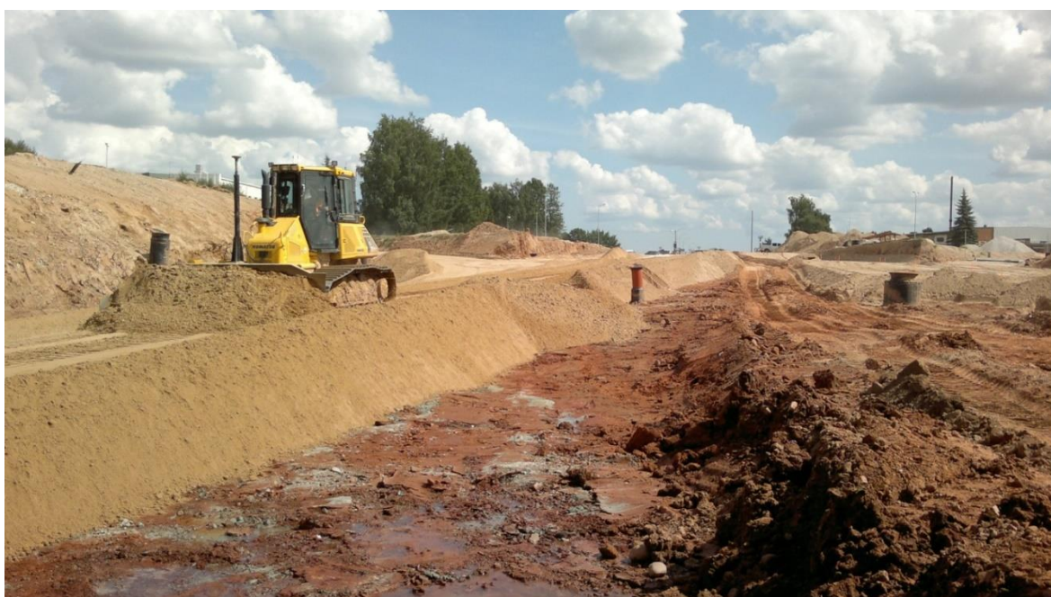
Joonis 1.7. Torutööde teostajate poolt rikutud ja väljakaevatud aluspinnase asemele karjäärimaterjali paigaldamine [erakogu]
