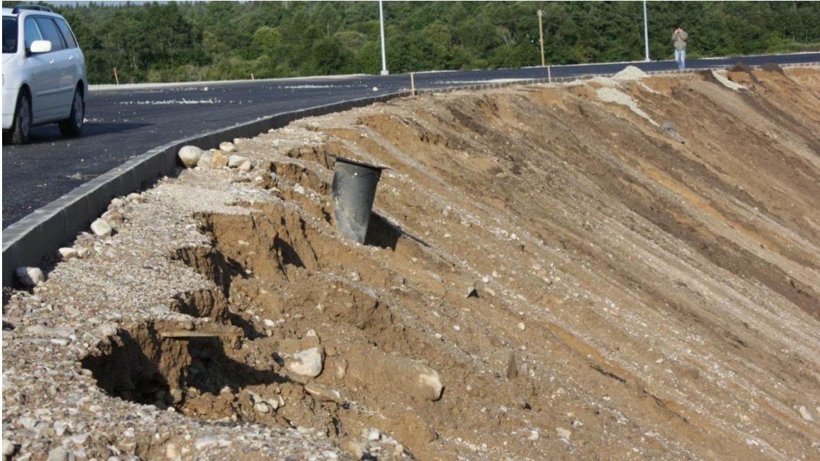
Joonis 4.4. Laiaulatuslik nõlva uhtumine, mis on tingitud hästidreenivast asfaltkattest [erakogu]
