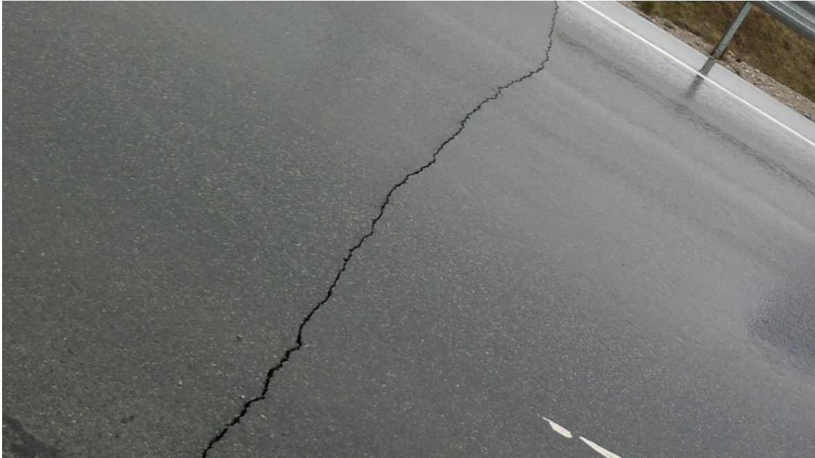
Joonis 3.9. Kompleksstabiliseeritud alusega teel on näha kindla vahemaa tagant korduvad põikipraad [erakogu]
