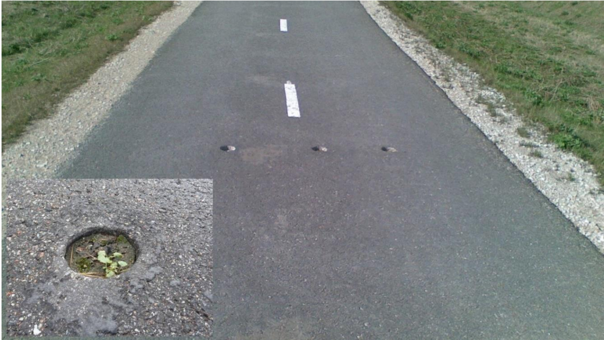
Joonis 4.11. Kergliiklustee, millel asuvad täitmata puurkehade võtmiskohad [erakogu]
