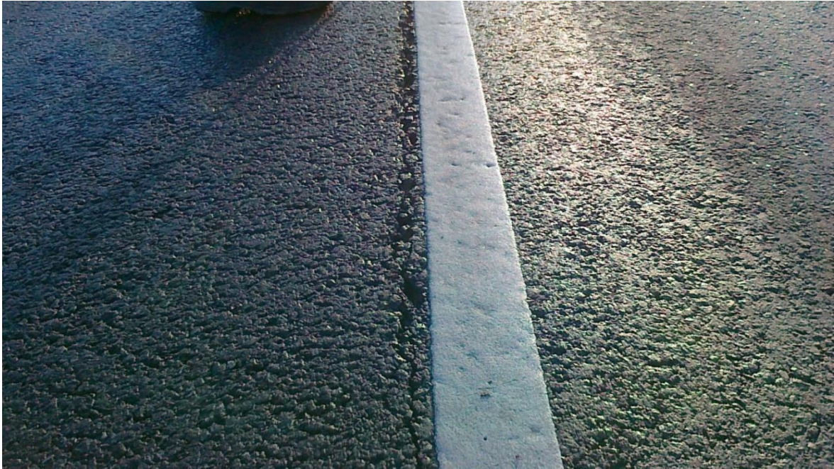
Joonis 4.9. Avanenud pikivuuki tee teljel [erakogu]
