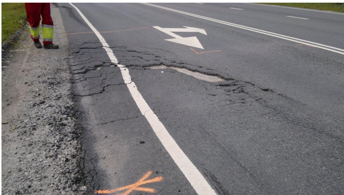
Joonis 4.2. Tugevalt kahjustunud kulumiskiht, mille põhjustajaks on määratud ja niiskele pinnale paigaldatud kulumiskiht [erakogu]
