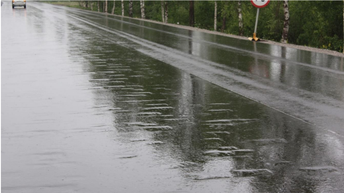
Joonis 4.14. Vastvalminud pealiskihile tekkinud lokaalsed deformatsioonid, mis on põhjustatud ajutise valgusfoori ette peatunud sõidukitest [erakogu]
