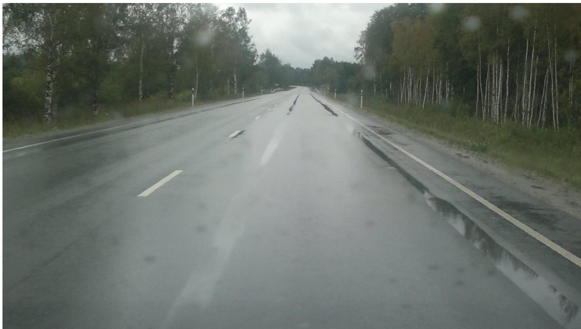
Joonis 4.13. Pikiroopad maanteelõigul [erakogu]
