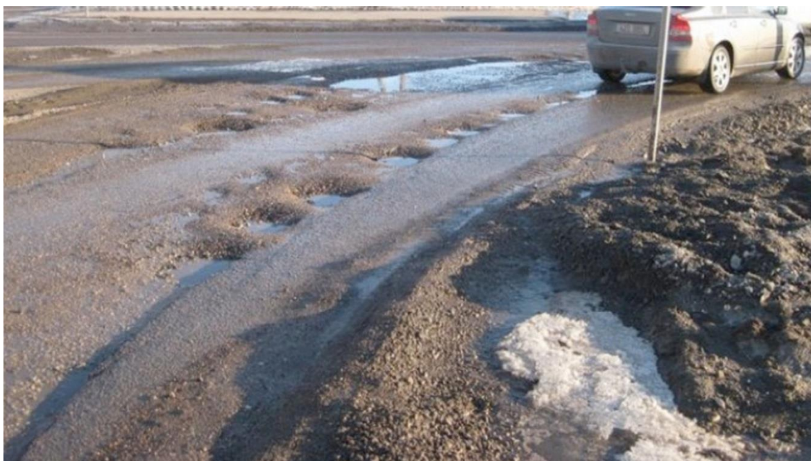
Joonis 4.15. Ajutisele ringristmikule paigaldatud AC 32 base lagunemine ilmastiku, naatriumkloriidi ja naastrehvide koosmõjul [erakogu]
