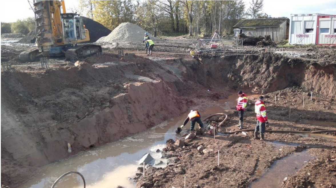
Joonis 1.2. Veetõrjetööd viadukti vaiamasina tarbeks rajatud alusel peale vihmasedu [erakogu]
