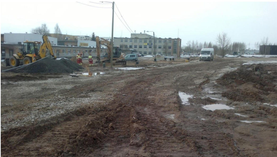
Joonis 2.3. Pealekantud pinnasega rikutud valmishitatud killustikalus [7]
