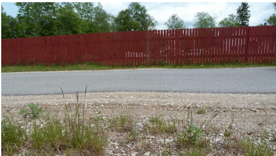
Joonis 1.15. Truubikaeviku tagasitäitematerjali ja tee muldkehamaterjali erinevate karakteristikute tõttu on truubi kohale tekkinud katte ebatasasus [erakogu]
