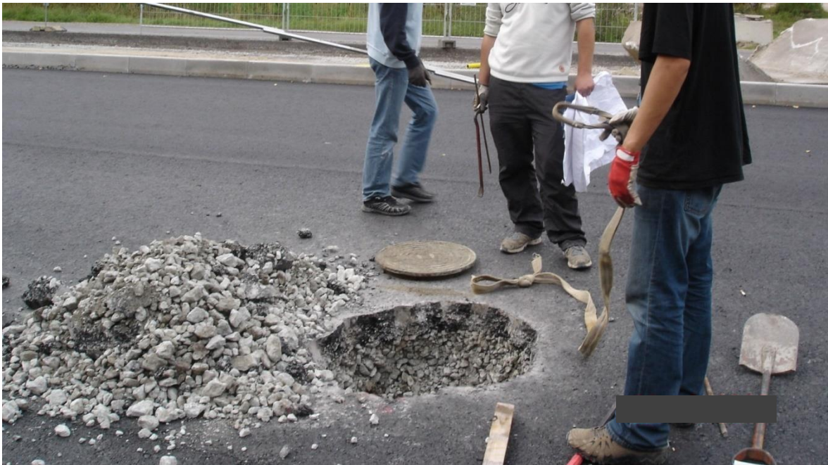
Joonis 4.8. Kaevu asukoha lahtikaevamine vahetult enne kulumiskihi paigaldustöid [erakogu]
