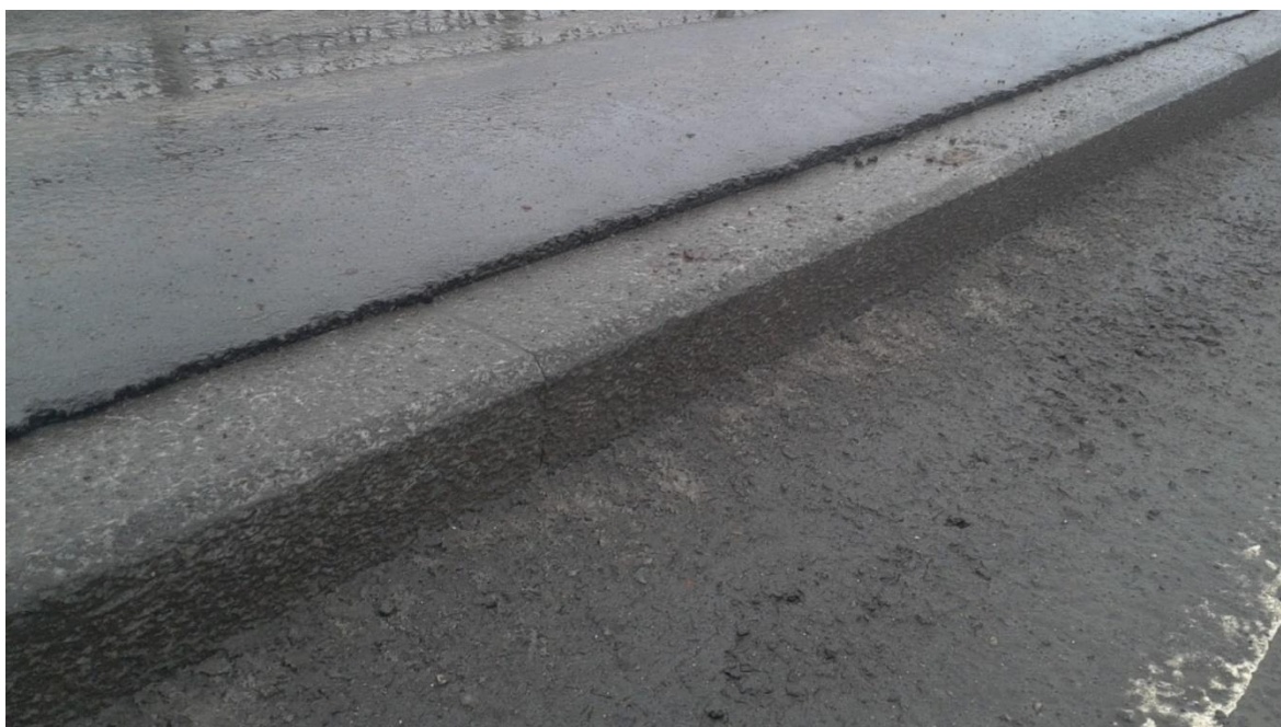
Joonis 2.4. Vale killustikufraktsiooni kasutamisest tingituna üleskerkinud kõnnitee asfaltkate viaduktil [erakogu]
