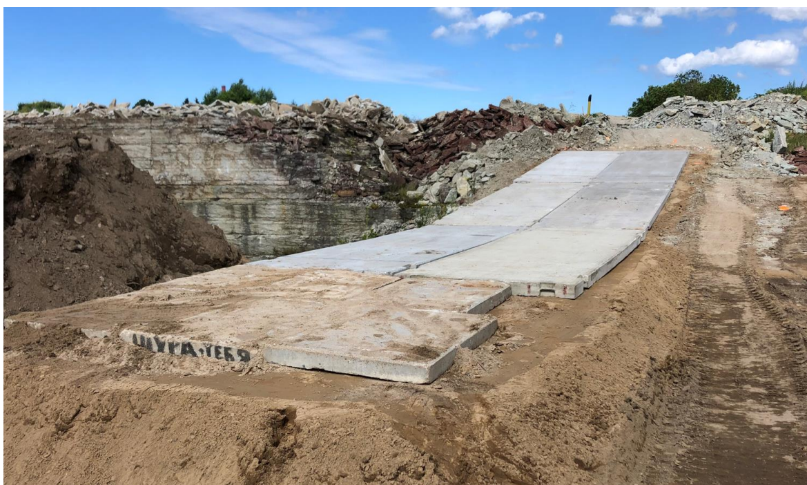
Joonis 1.9. Väo liiklussõlmes 110kV kaabli kaitsmiseks paigaldatud betoonplaadid [4]
