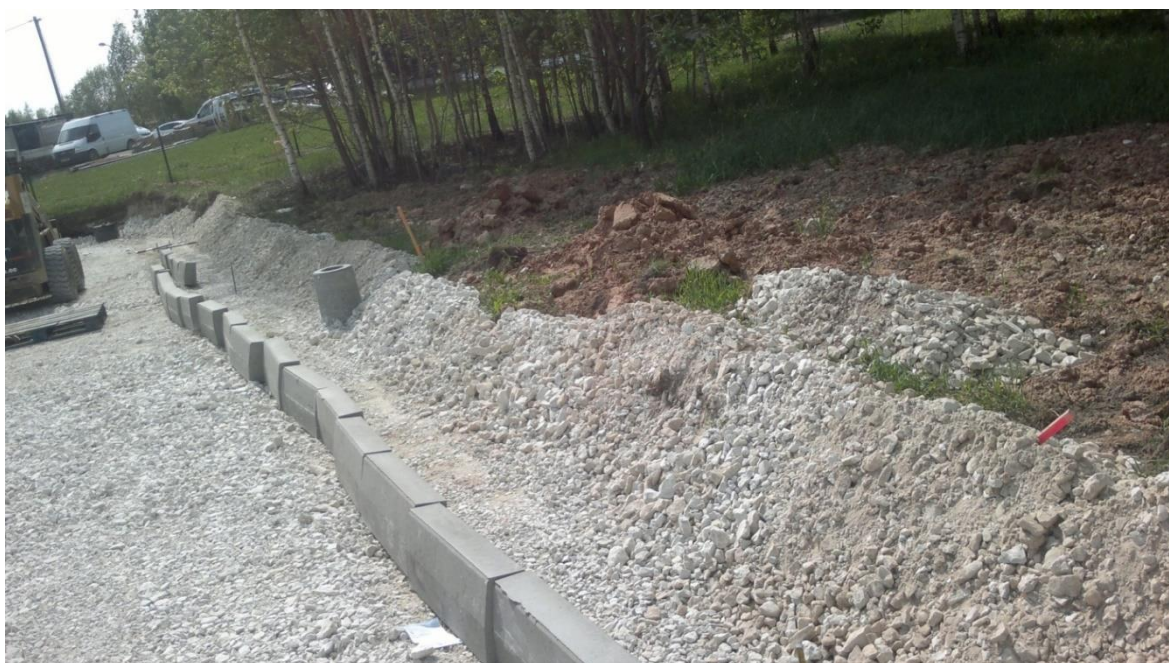
Joonis 2.2. Äärekivide paigaldustööde käigus haljasalale paigaldatud killustikmaterjal [erakogu]
