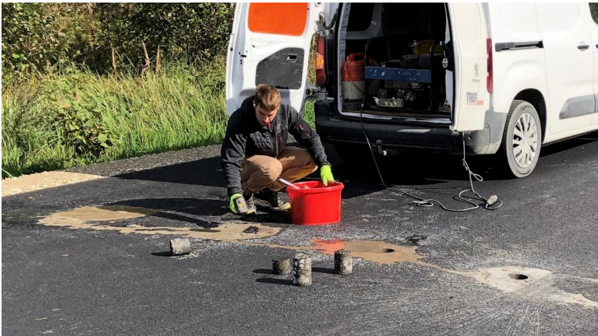
Joonis 4.12. Puuraukude täitmine külmseguga vahetule peale puurkehade puurimist [erakogu]
