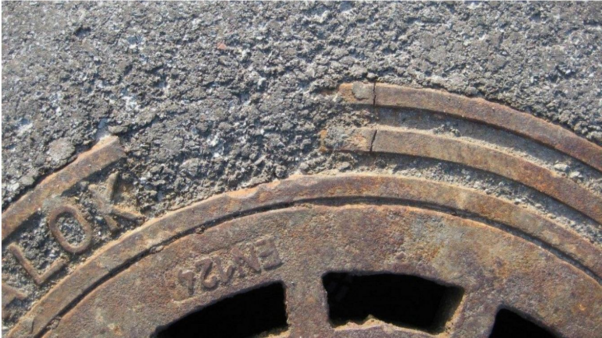
Joonis 4.7. Tihendamistööde käigus murtud restkaevukrae [erakogu]
