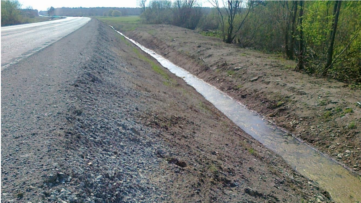
Joonis 1.13. Uus kraav ja ladustatud pinnas teemaa äärealale [erakogu]
