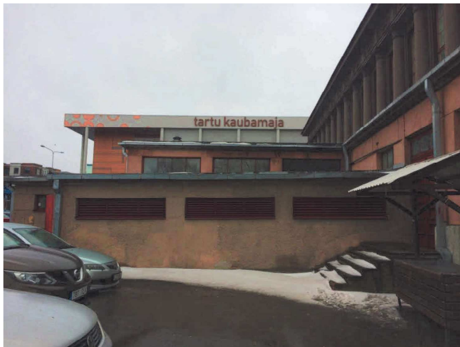
Foto 41 Vaade kalahalli Emajõe poolse kaldtee maapealsele osale ja lihahalli idapoolsele välisuksele ja trepile
