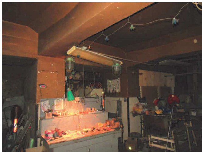
Foto 26 Ruum 034. Vahelae kandekonstruktsioonid
