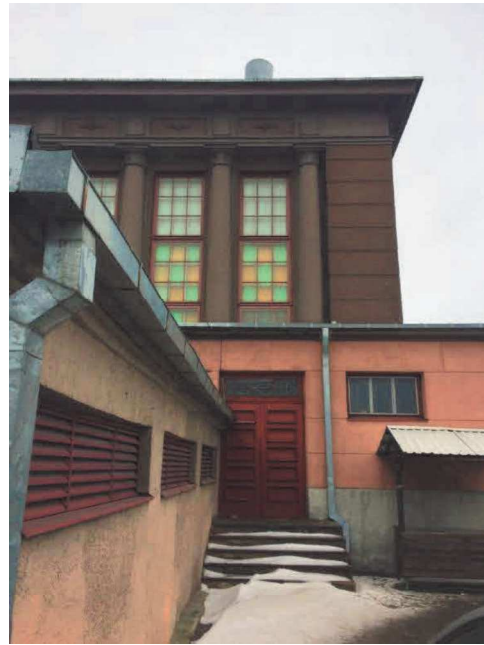
Foto 40 Vaade lihahalli idapoolsele välisuksele ja trepile
