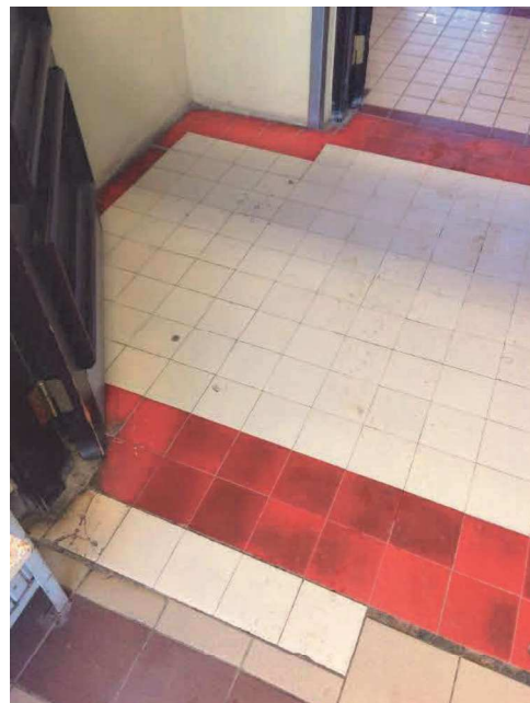
Foto 9 Metlahh-plaatidest põrand kala- ja põhihalli vahelises koridoris
