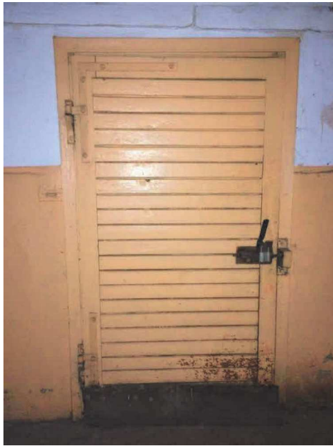
Foto 35 Säilinud algupärane külmkambri uks (number U 038)
