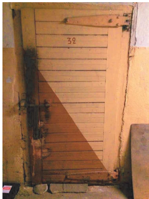
Foto 33 Säilinud algupärane külmruumi uks (number 032)
