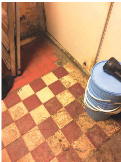
Foto 16 Säilinud metlahhplaatidest põrand kalahalli Vabaduse puiestee poolses trepikojas
