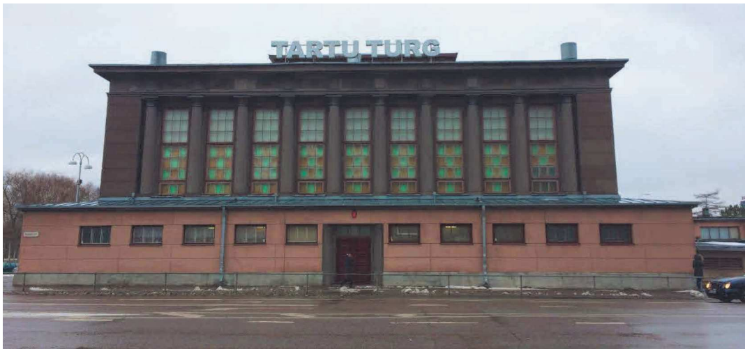
Foto 43 Turuhoone Turu Vabaduse puiestee poolne fassaad (vaade edelast)
