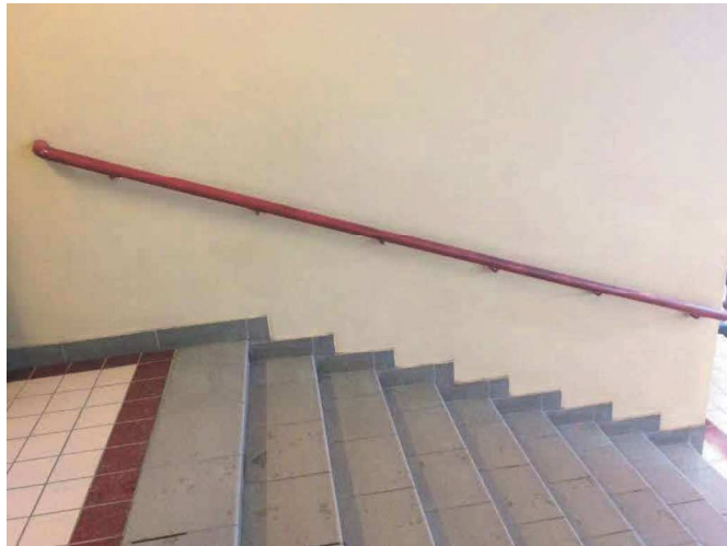
Foto 10 Trepikäsipuu kala- ja põhihalli vahelisel trepil
