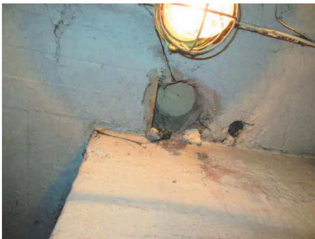
Foto 29 Olemasolev kasutuseta läbiviik keldri vahelaes ruumis number 028
