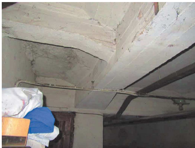
Foto 24 Keldri vahelae raudbetoonkonstruktsioon
