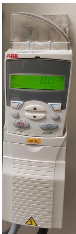
Рисунок 2.19 ABB ACS310 – 03E – 04A5 – 4 – Частотный преобразователь (фото автора)
