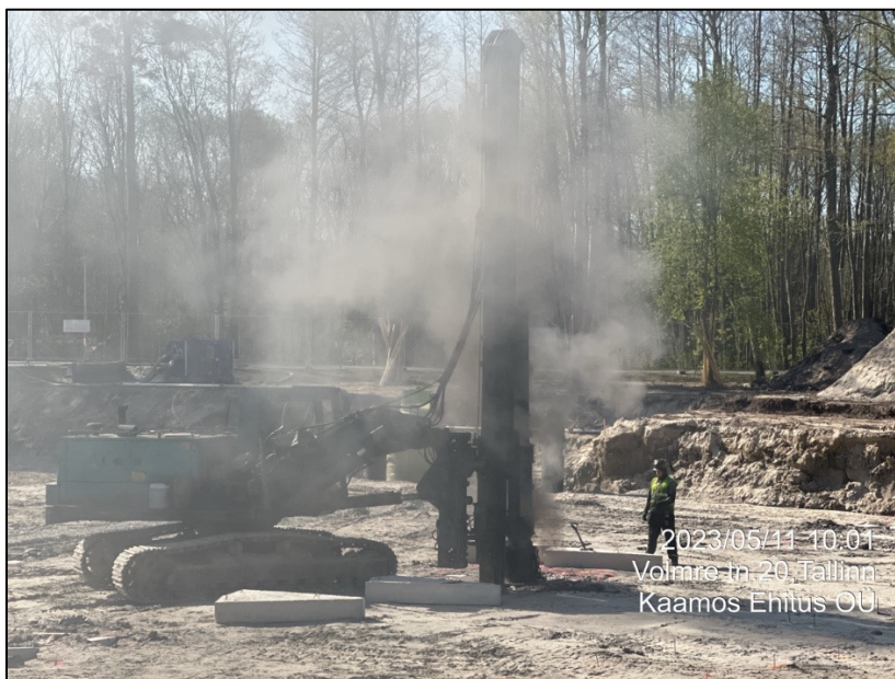
Joonis 6.3 Kiilvaiade rammimine torudiiselhaamriga varustatud vaiamasinaga
