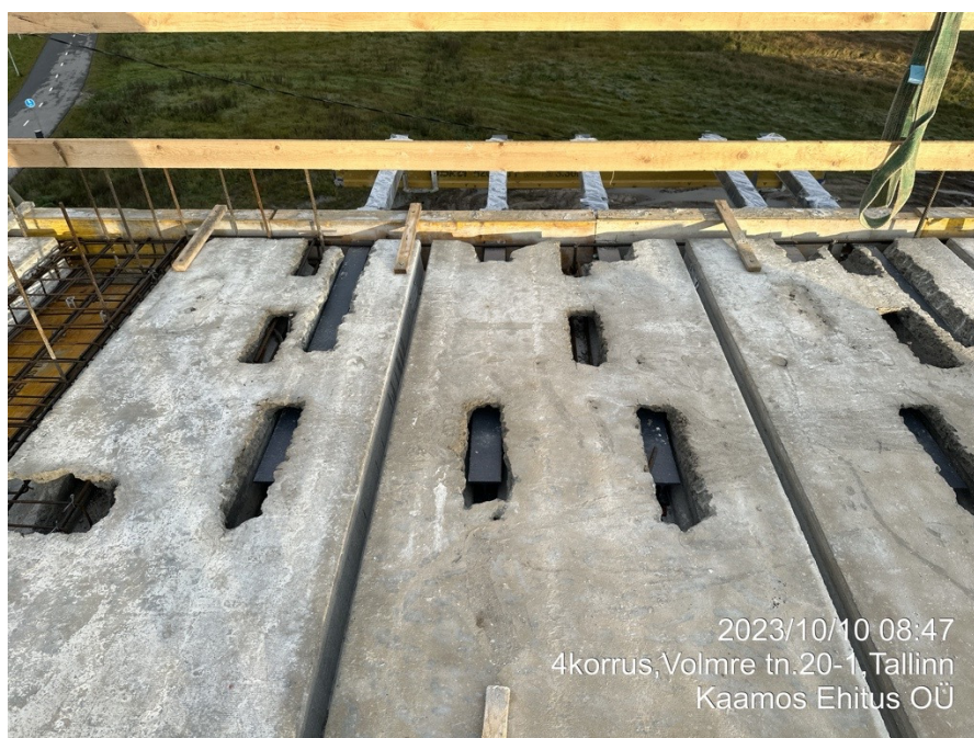
Joonis 6.8 Rõdutilade paiknemine õõnespaneelide õõntes
