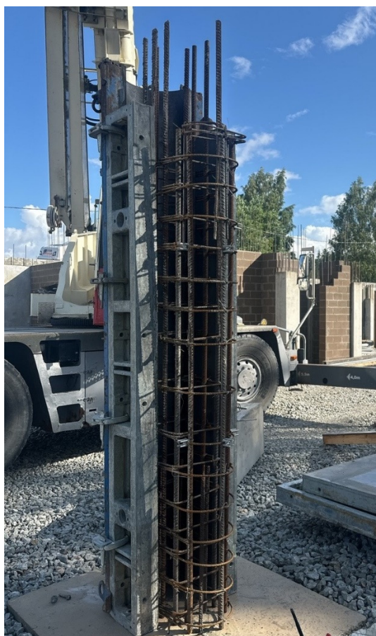
Joonis 6.5 Monoliitsete postide armatuur koos osalise raketisekilpide paigaldusega
