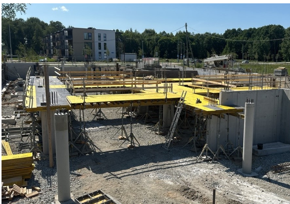
Joonis 6.6 Tala aluste raketisekilpide paigaldus enne armeerimistööd
