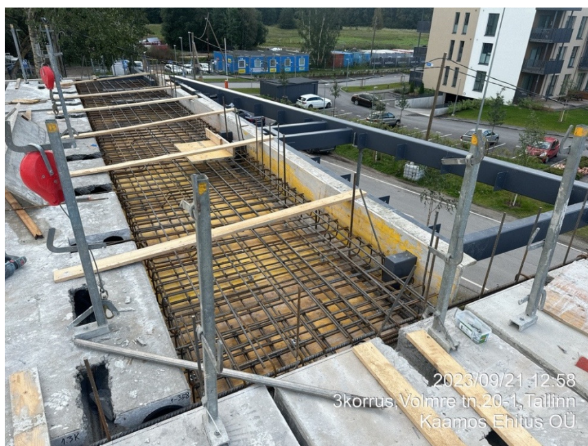
Joonis 6.9 Monoliitse vahelaosa armeering koos küljeraketisega
