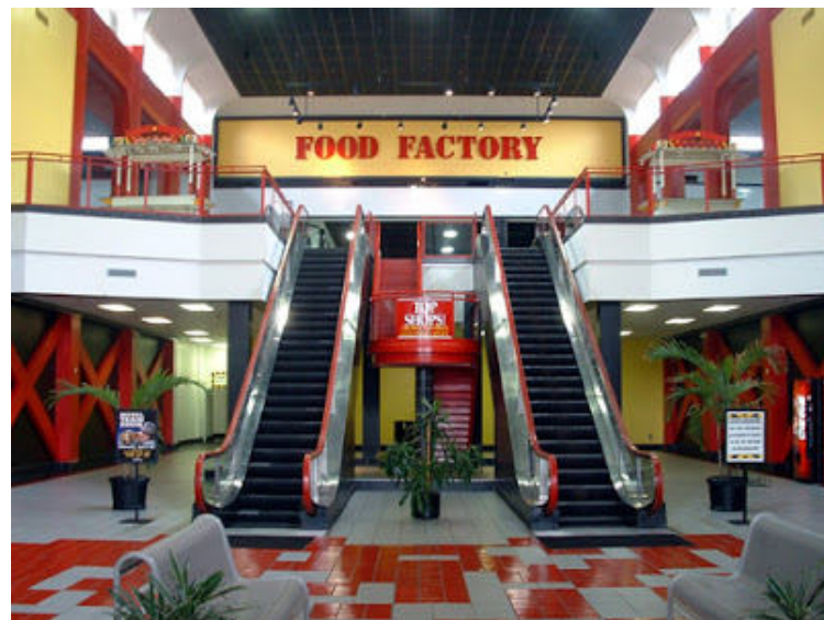
ILL. 18 100 Oaks Mall Kaubanduskeskus enne rekonstrueerimist Autor: Chris Freeman
