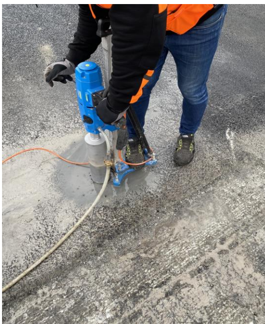
Joonis 3.2 Kattest puurkehade võtmine
