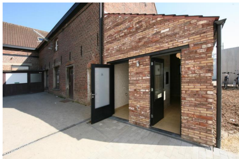
Joonis 16. Sanitaarkompleksi abihoone. Fassaadil korduskasutatud tellised, siseruumides korduskasutatud keraamilised plaadid ning suur osa mööblist.
