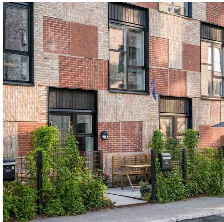
Joonis 19. Recourse Rows. Kortermaja. Fassaadil kasutatud tellismüüritisest väljalõigatud paneele.
