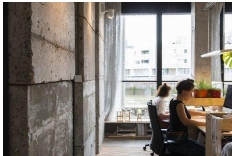
Joonis 13. BlueCity Offices. Endise diskoteegi ümberehitusprojekt büroohooneks. Siseseintena on korduskasutatud olemasolevatest seintest usteavade jaoks väljalõigatud betoonplokk.
