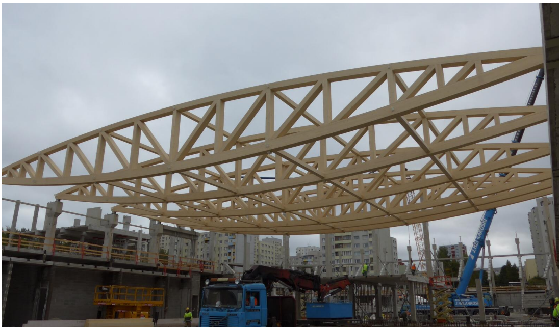
Foto 8.1. Tallinna Tondiraba jäähalli katusesõrestikud (foto: Arcwood)
