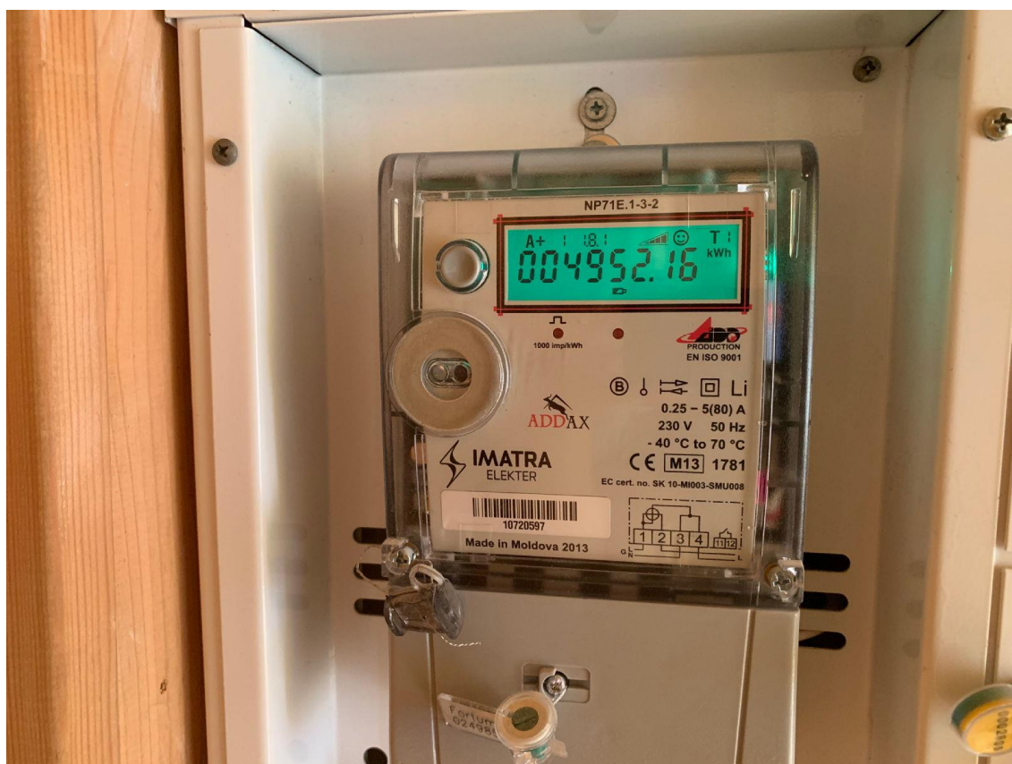
Joonis 4.2 - Elektriarvesti töös. [2]
