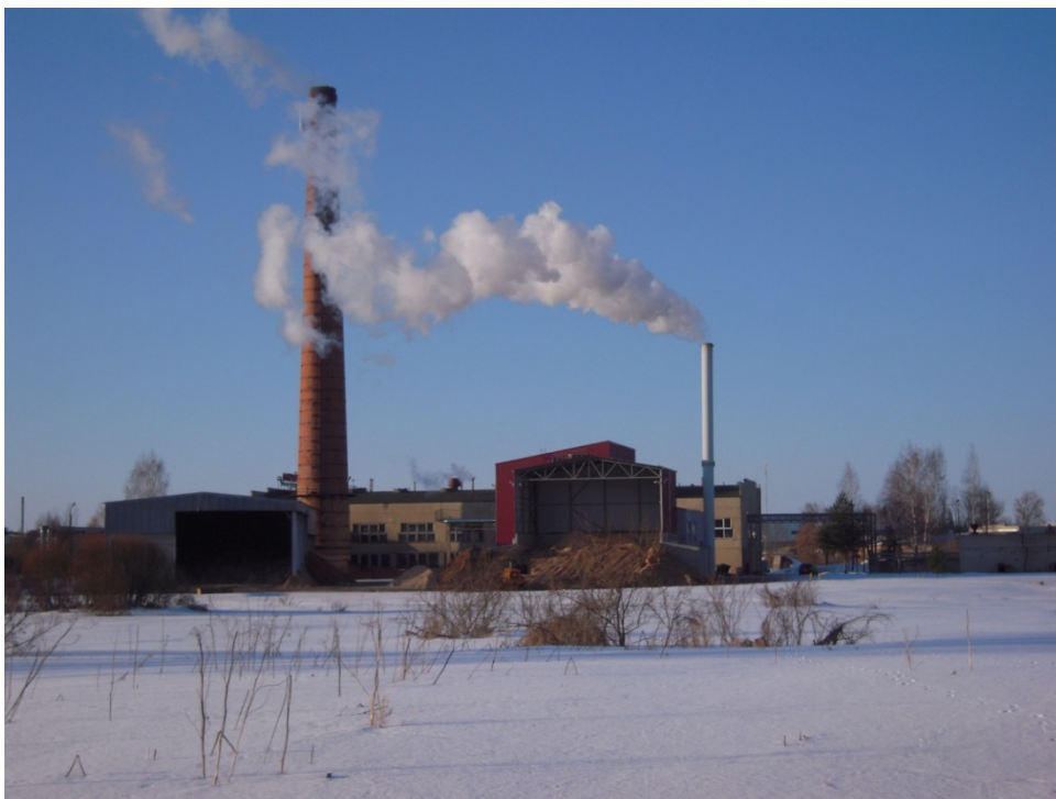
Sele 3.1 Võrusoo katlamaja. Esiplaanil paremal 10 MW uus hakkpuidu katlamaja. Esiplaanil vasakul vana hakkpuidu katla ladu. Tagaplaanil vana katlamaja.
