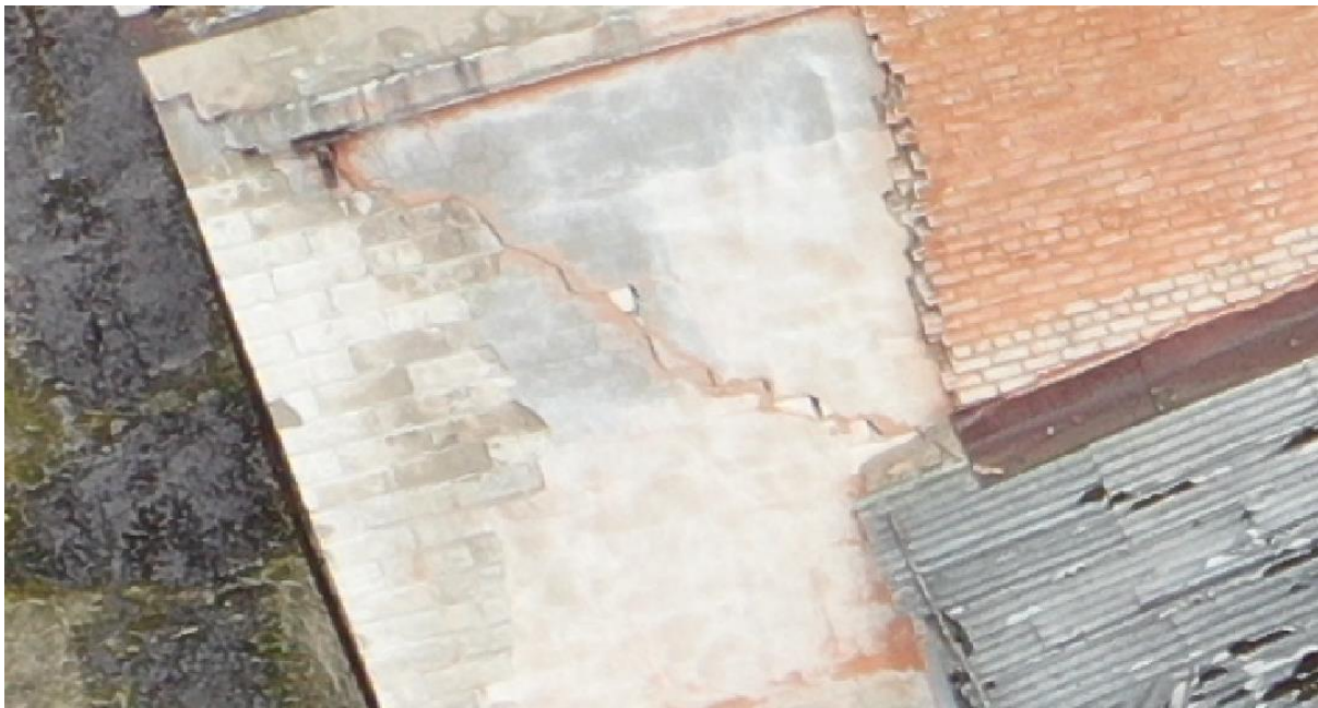
Joonis 5.7 Mõra tuhaplokkidest müüritises
