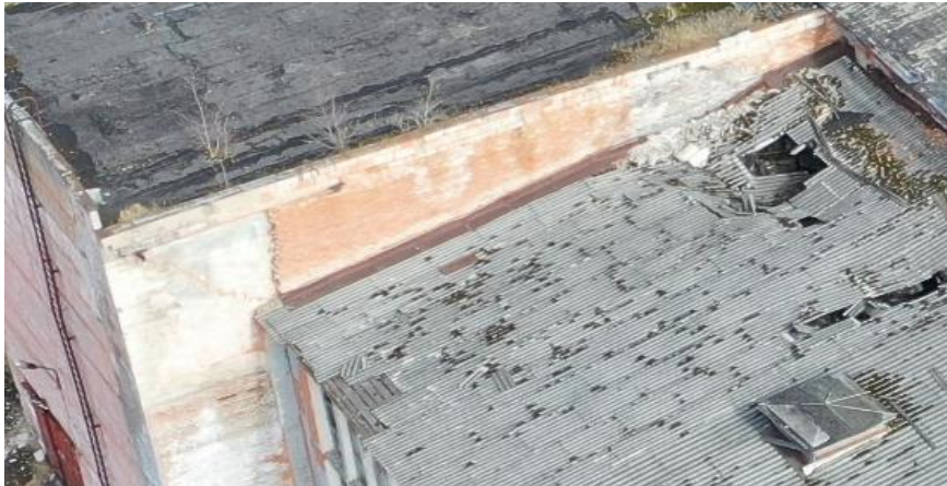
Joonis 6.7 Katuse üleval ääres olev tuhaplokist ala
