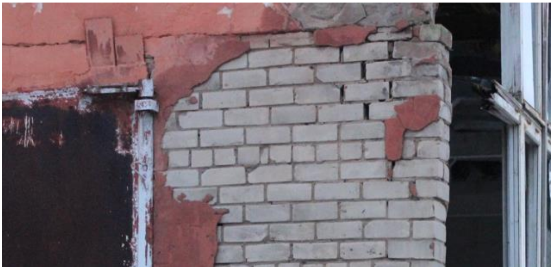
Joonis 5.4 Ohtlikus seisus silikaattellised
