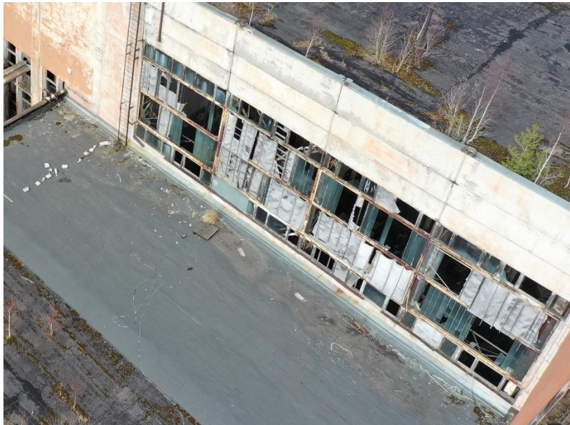
Joonis 6.6 Aknad, mille all puudus oletatav tuhkpaneelide rida
