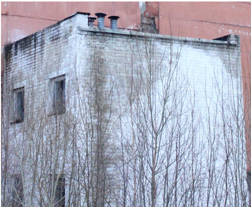
Joonis 5.5 Kulunud silikaattellisest müüritis
