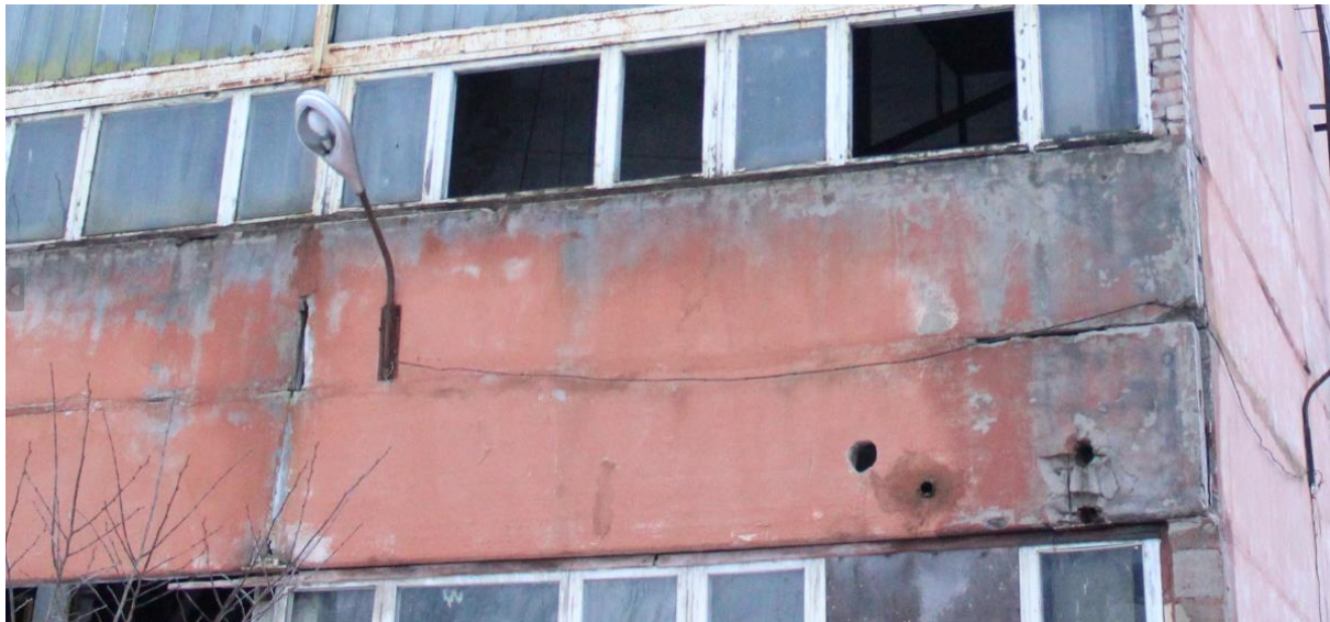
Joonis 5.1 Tuhkpaneeli näha olev sarrus
