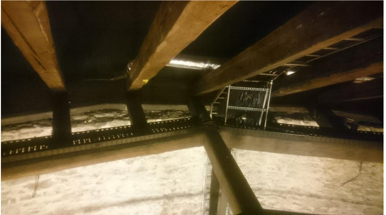
Joonis2. Kaabliredelite paigutus
