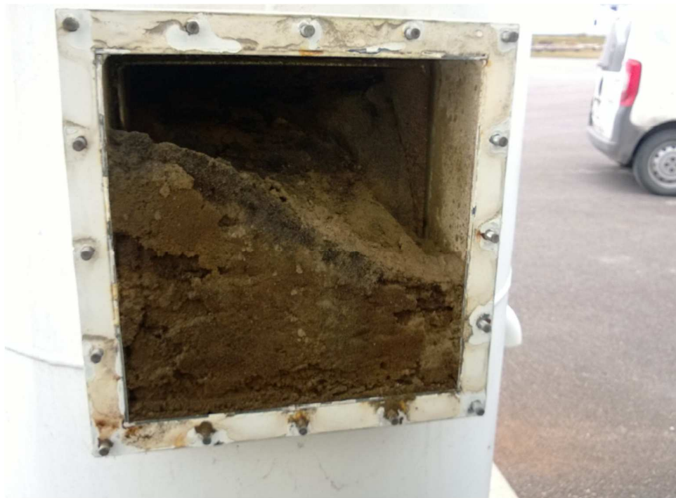
Sele 5.9 Pelleti tolm ja põlemisjääd korstna jalas
