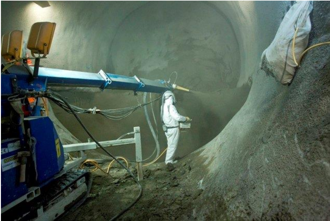
Joonis 18 Pritsbetoon toetustööd ( http://www.rmfttraining.co.uk/crossrail-lessons-inform-new-sprayed-concrete-guide/ )
