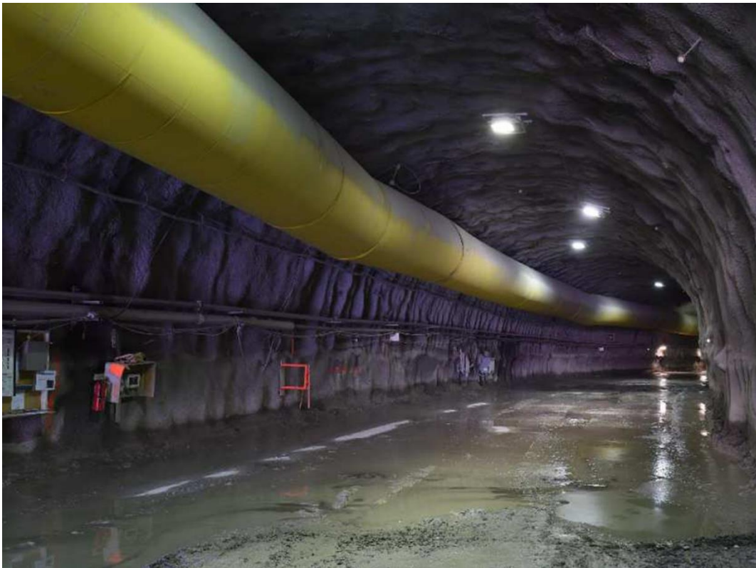
Joonis 19 Tunneli ventileerimine läbindamisel [17]
