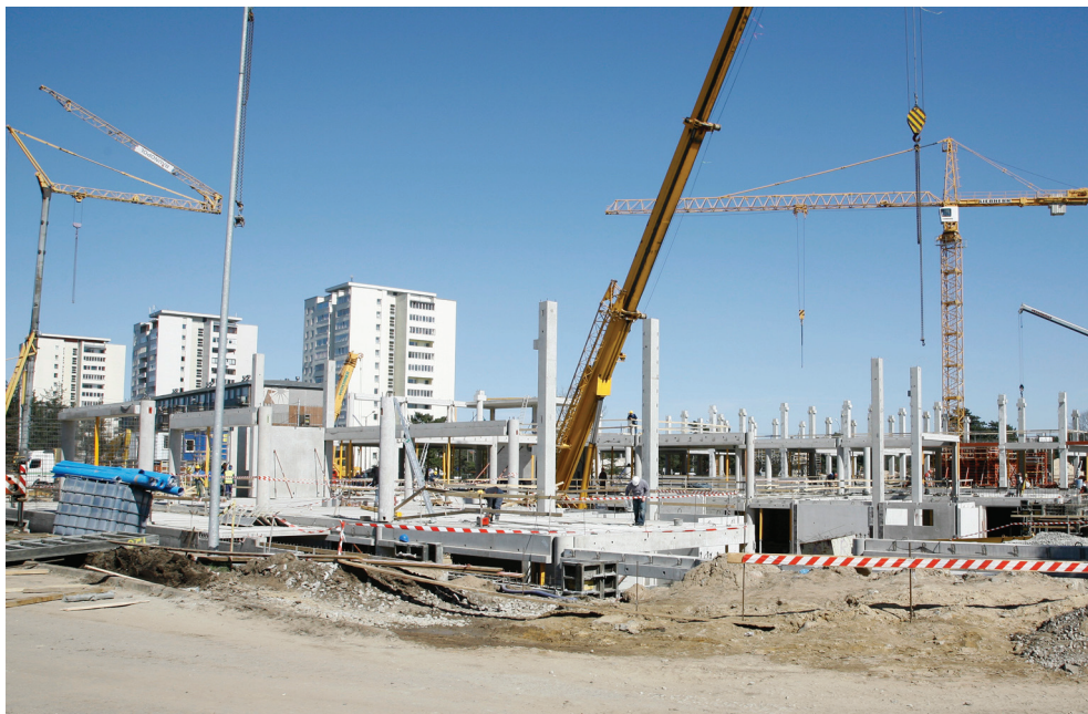
Raamatukogu uue hoone ehitus algas 11. veebruaril 2008
