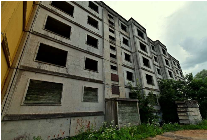
Joonis 29. Vaade hoone eest
