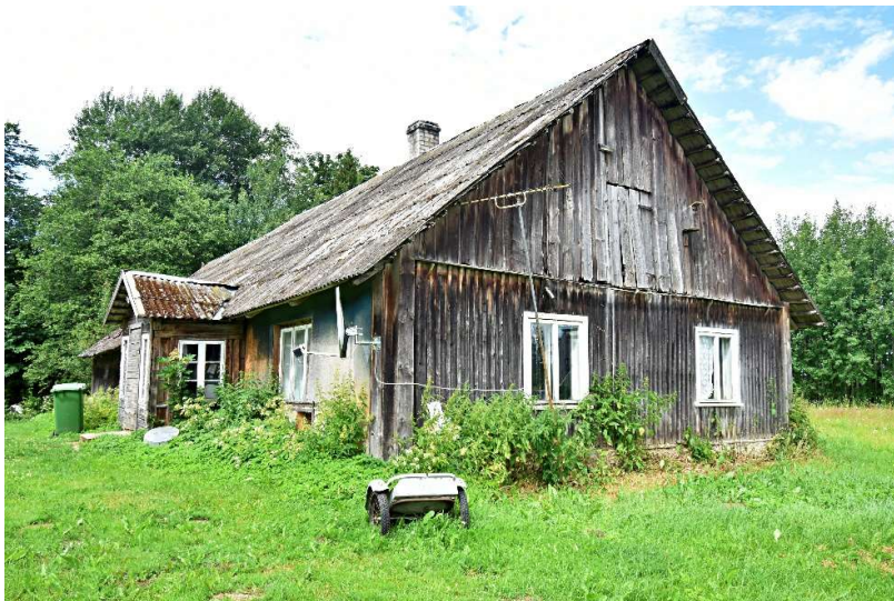
Joonis 24. Vaade taluhoonele
