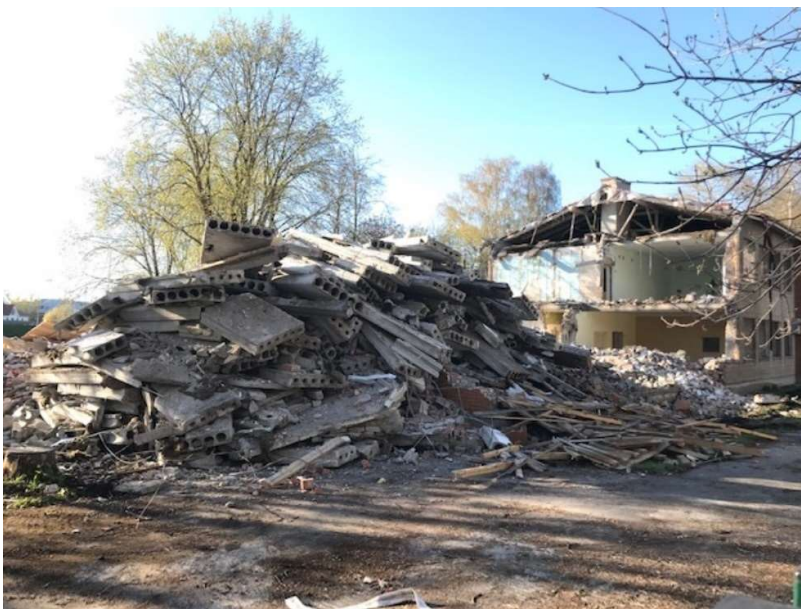
Joonis 41. Vaade lammutatavale objektile ja tekkinud lammutusjätmetele
