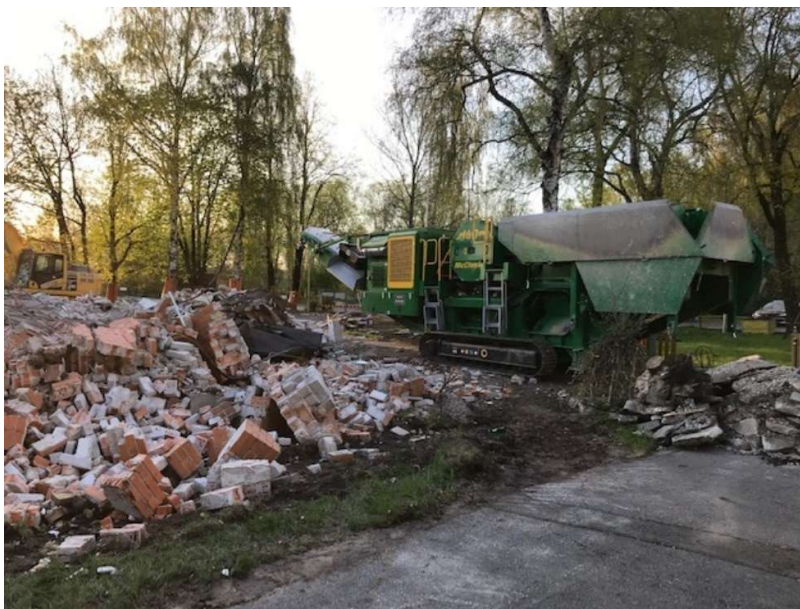
Joonis 42. Objektile kohale transporditud purustusseade
