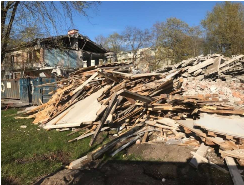
Joonis 37. Eraldi hunnikutes hakkesse minevad puidujäätmed ning purustisse minevad kivi- ja betoonijäätmed
