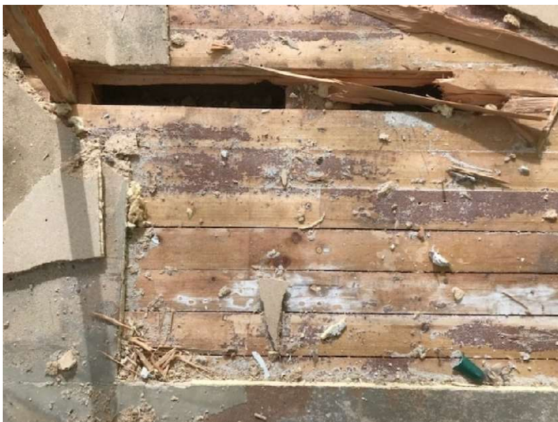
Joonis 34. Avatud esimese korruse põranda tarind
