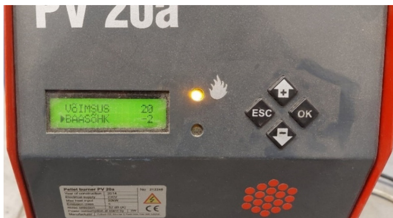
Joonis 3.10 Liigõhu reguleerimine katla STI20VTP-Pelle pelletipõletil
