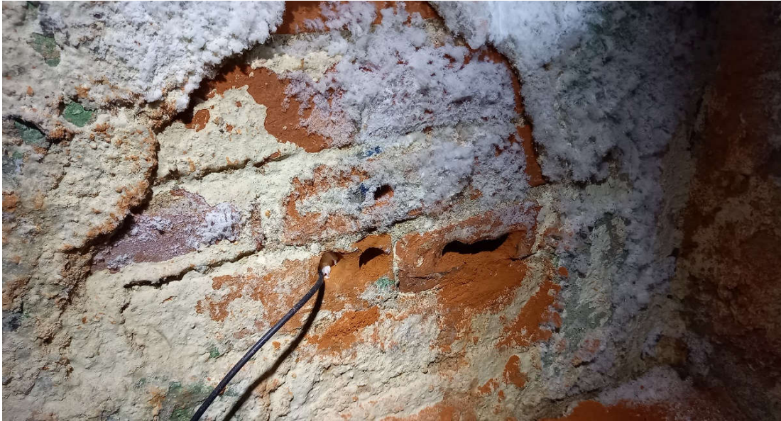
Joonis 12. Asukohas Sein 1 Pinnale kristalliseerunud sool enne krohvi paigaldust.
