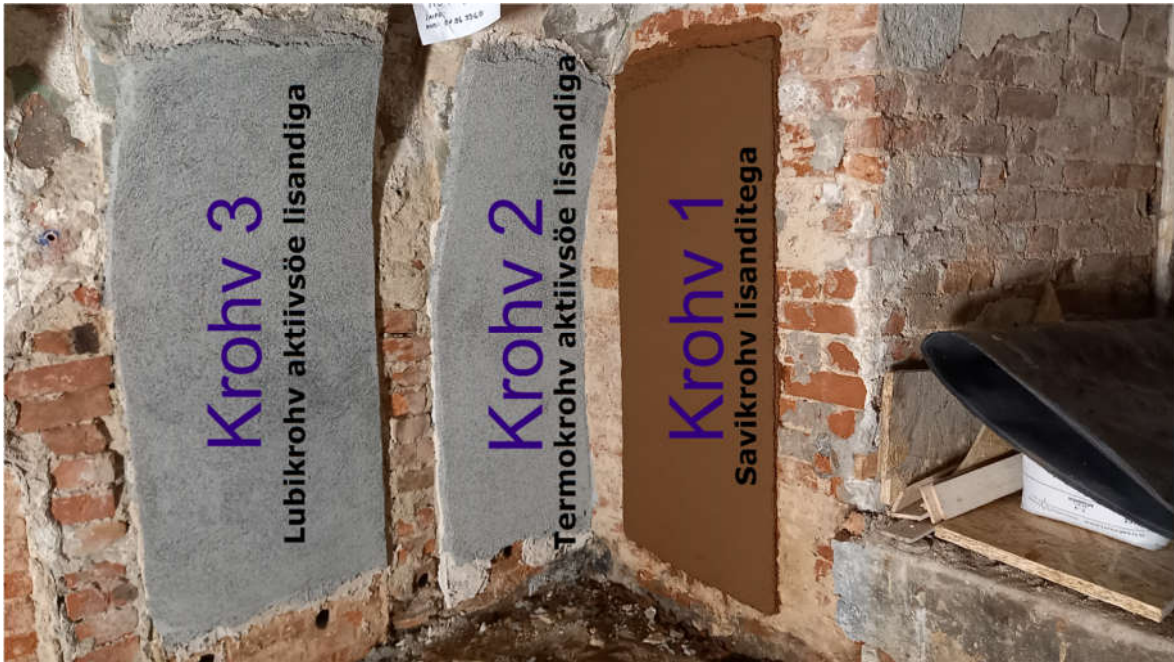
Joonis 19. Krohvide paiknemine seinal 1
