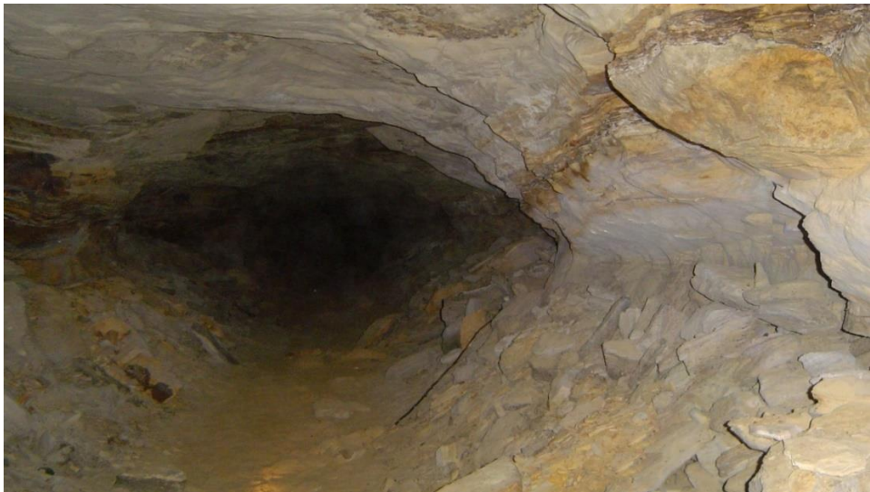
Pilt 2.2 Mäerõhu ilming fosforiidikaevanduses
