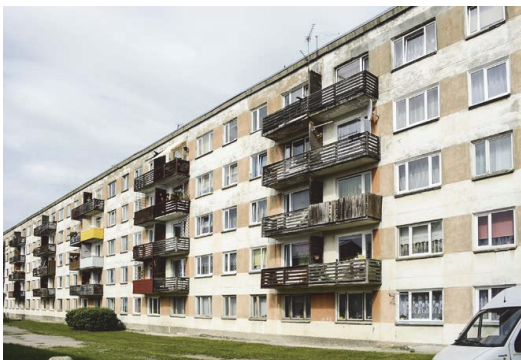
Abb. 8: Typisches Wohngebäude aus der Sowjetzeit
