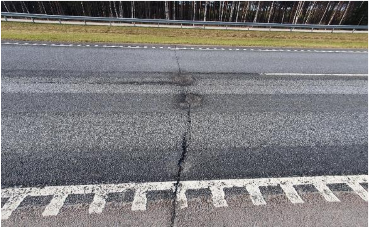
Joonis 2.24 Põikprao muutumine lõõkaukudeks
