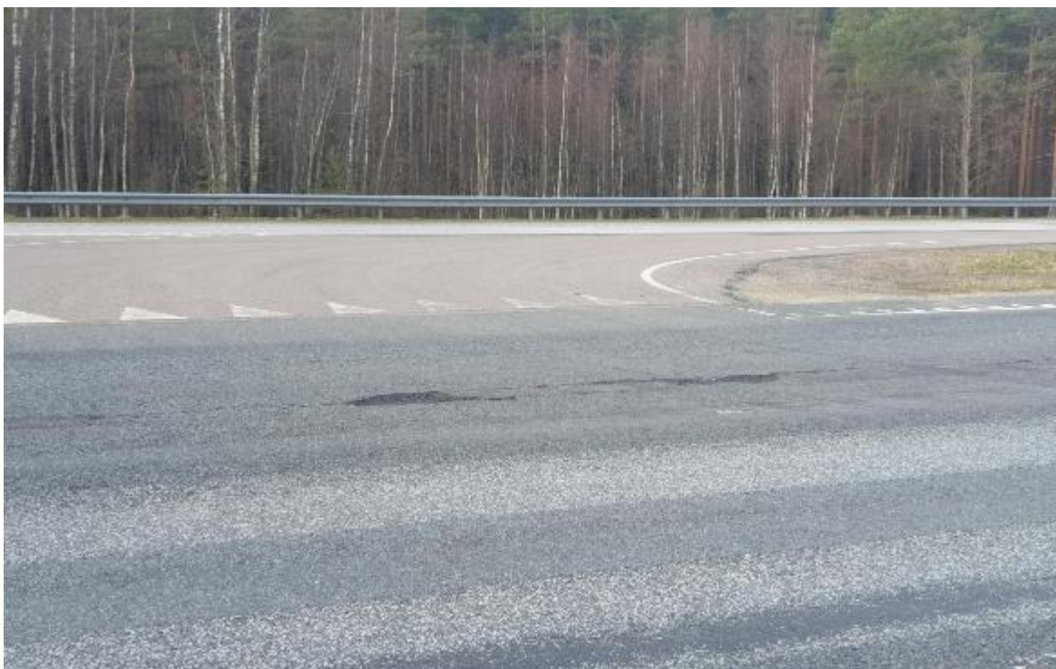
Joonis 3.24 Teekattemärgistuse tagajärjel tekkinud kahjustus
