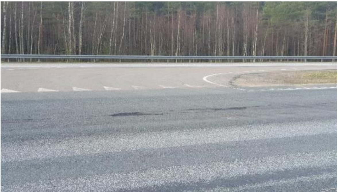
Joonis 2.25 Pikiprao tekke algfaas
