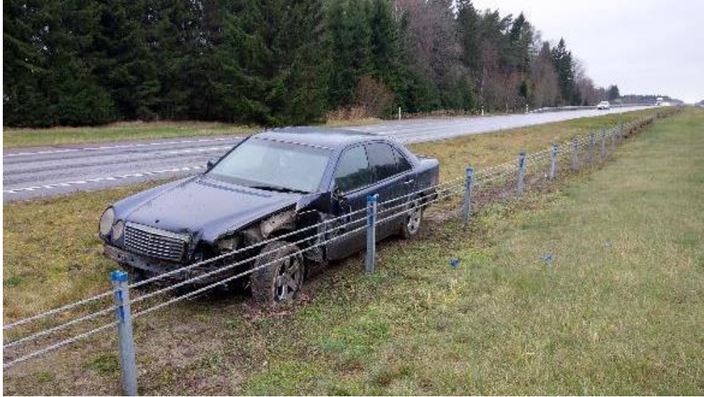
Joonis 2.8 Trosspiire on täitnud oma eesmärgi
