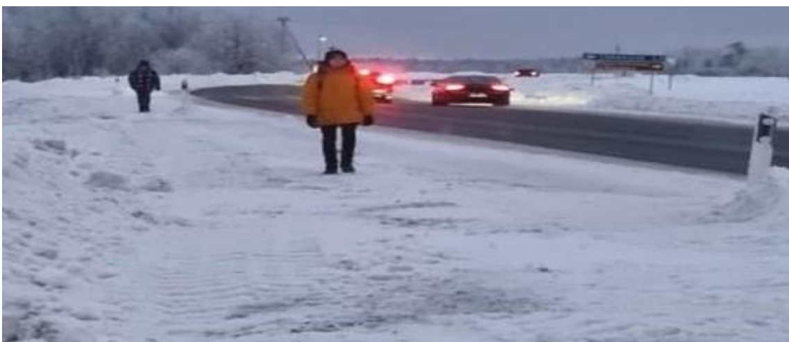
Joonis 3.22 Turvalisuse huvides laiemalt lahti lükatud teepeenar
