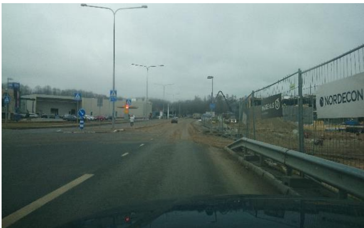
Joonis 2.19 Ehitusplastilt kattele veetud pinnas
