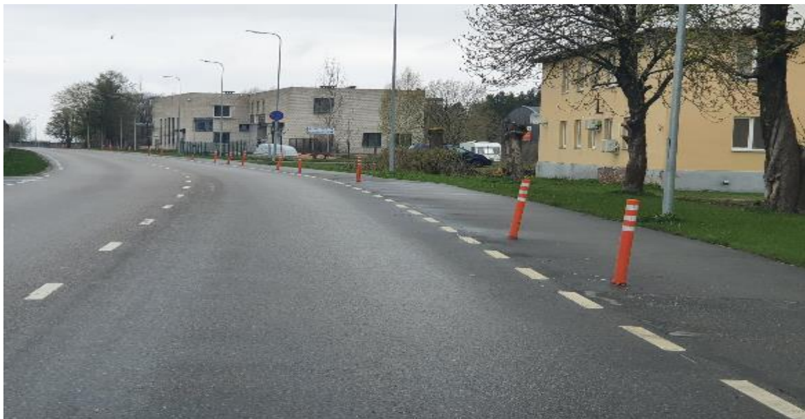
Joonis 3.23 Aastaringelt kõnniteed eraldavad ja talihoolet segavad tähispostid Autori erakogu
