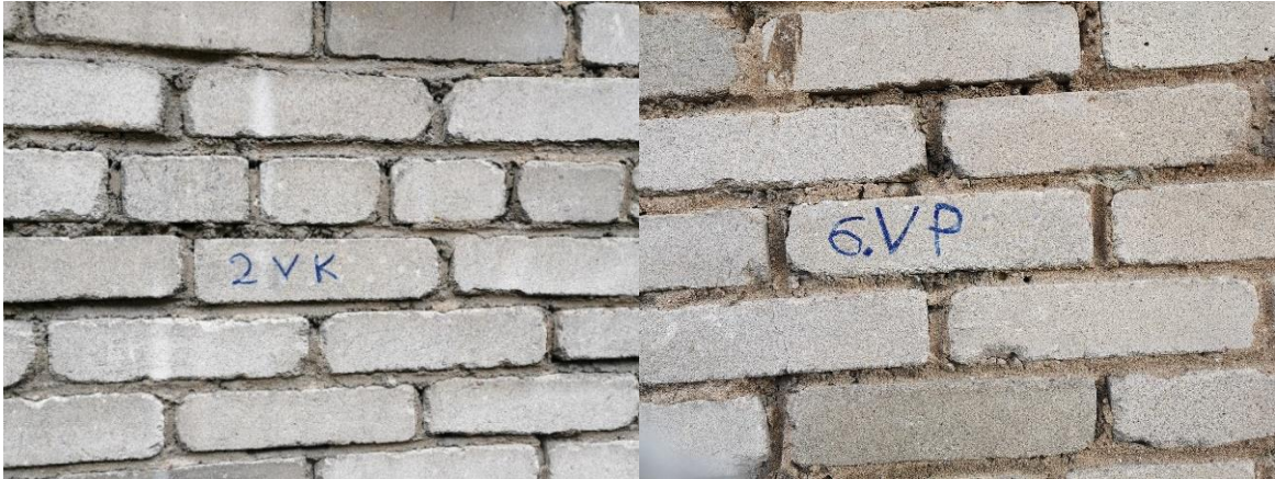
Joonis 4.2 Lähifotod Keskpuiestee 43 silikaatkividest müüritise üldisest seisundist. [31]
