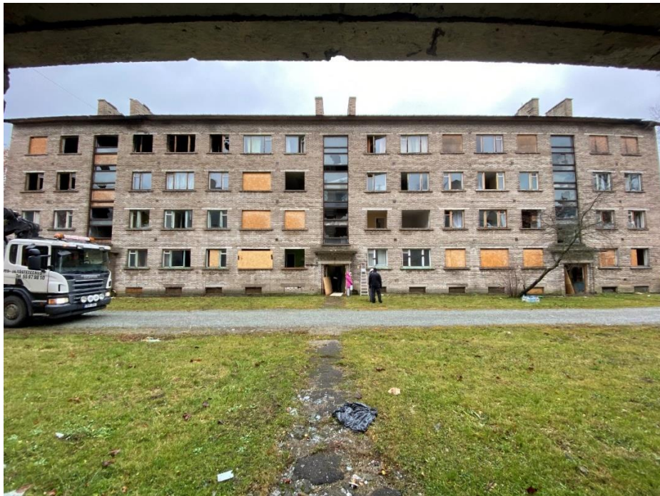
Joonis 4.1 Foto Keskpuiestee 43 hoone välisfassaadist.
