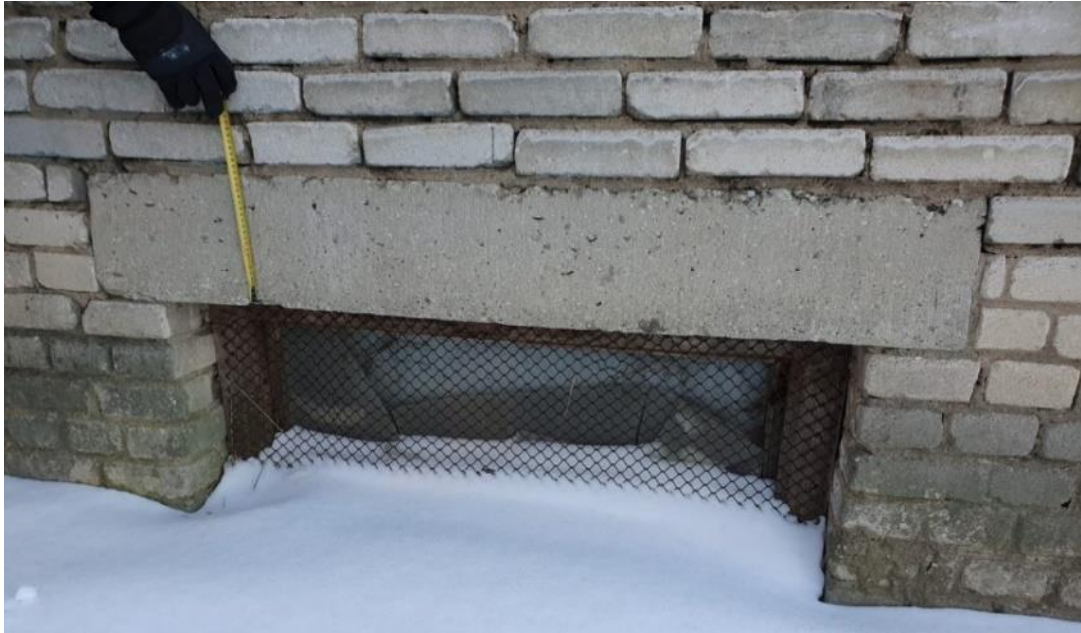
Joonis 4.3 Näidifoto Keskpuiestee 43 raudbetoonist ülemisest aknasillusest (Foto: M. Kiviste).
