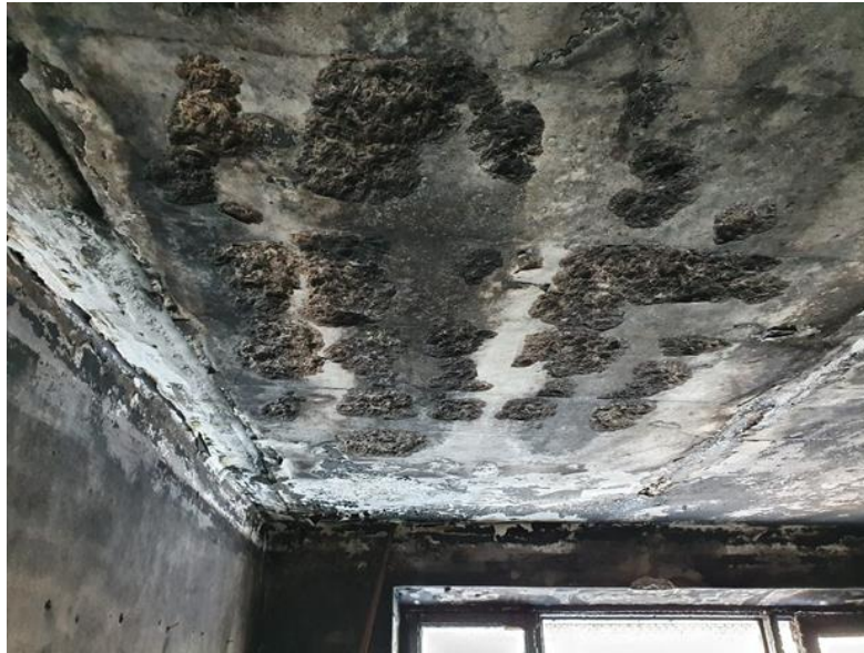
Joonis 4.5 Foto põlengutunnustega õõnespaneelide alumisest pinnast (I korrus korter 4) (Foto: M. Kiviste).
