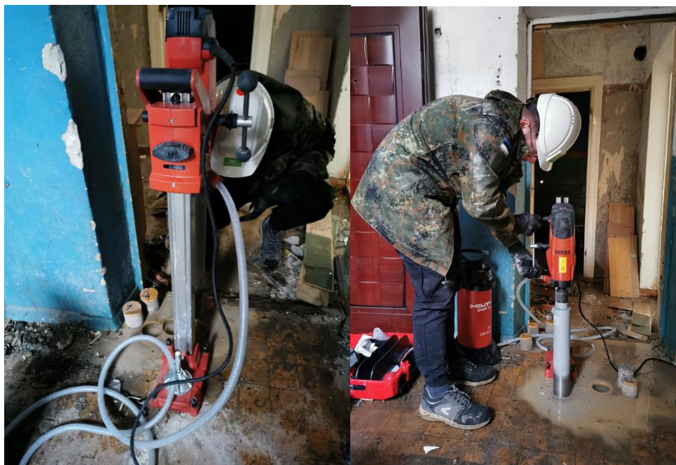
Joonis 3.3 Foto teemantpuurimise komplektist Hilti fikseeritud Keskpuiestee 43 (Kiviõli) trepimademe külge (vasakul); betoonkatsekehade (kärnide) puurimine (paremal) (Foto: M. Kiviste).
