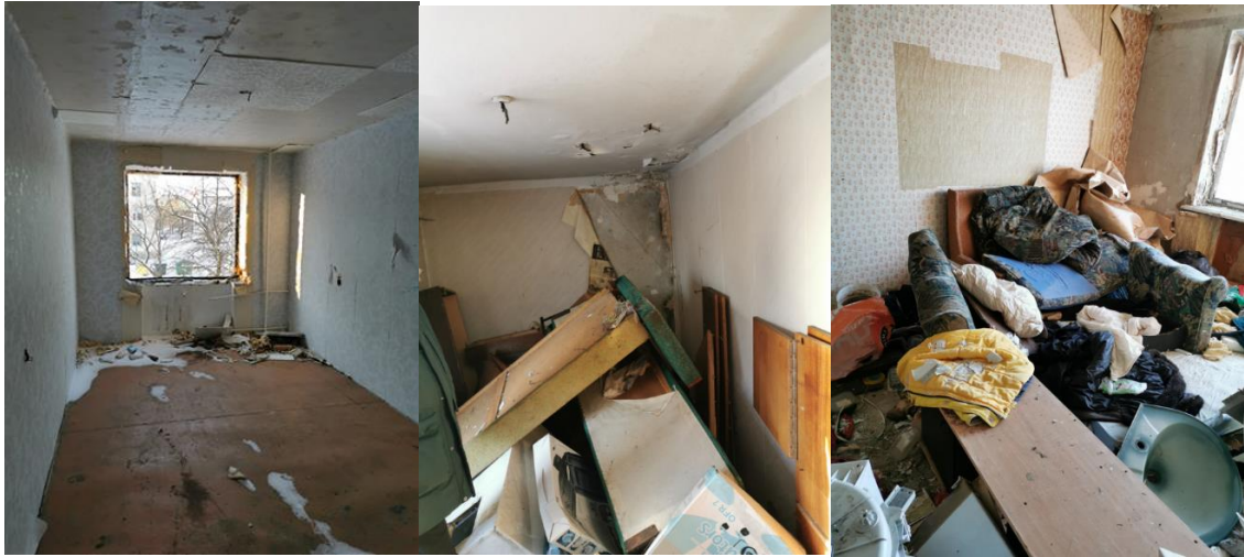
Joonis 4.4 Fotod Keskpuiestee 43 korterite seinte siseviimistluse ja sisustuse seisundist (Fotod: M. Kiviste).
