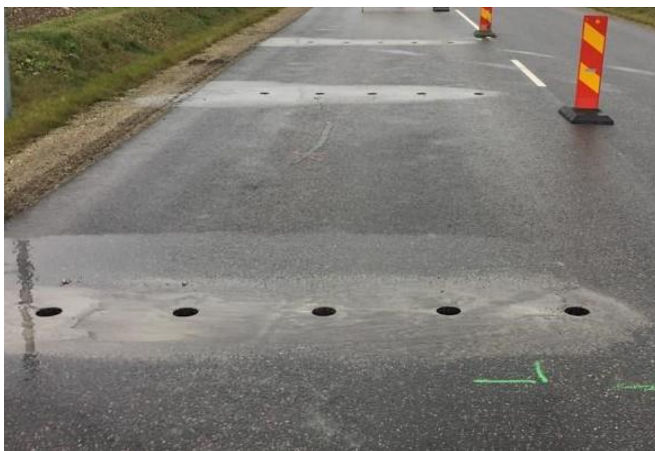
Joonis 2.9 Objekti D puurkehade võtmise skeem
