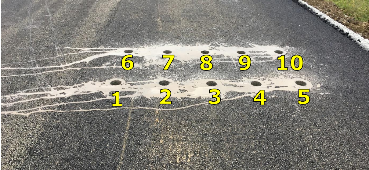
Joonis 2.1 Objekti A puurkehade (1 - 10) võtmise asukohad.
