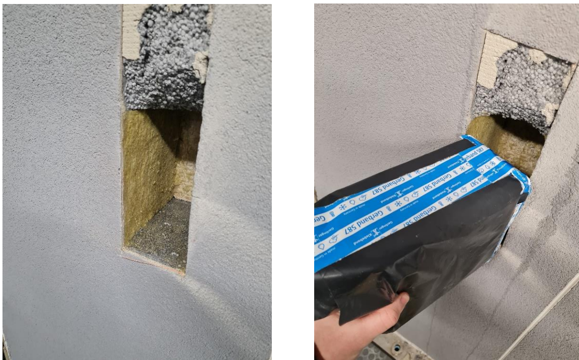
Joonis 18 Tühimik peale katsekeha eemaldamist (vasakul). Tühimike täitmine kilega kaetud villatükiga (paremal)
