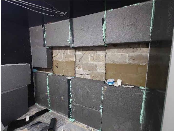
Joonis 13. Soojustuse paigaldamine (vasakul) ning serv-punkt meetodiga soojustuse paigaldus (paremal)
