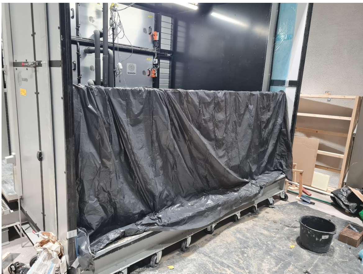
Joonis 9. Kilega kaetud müüritis välja kuivamise vähendamiseks
