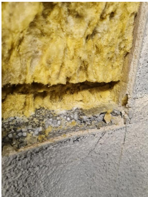
Joonis 23. Villavöö alumises, välimises servas oli märgata jääkristalle (vasakul). Iseäranis suur jää kogus oli tüübli piirkonnas (paremal)
