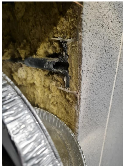
Joonis 23. Villavöö alumises, välimises servas oli märgata jääkristalle (vasakul). Iseäranis suur jää kogus oli tüübli piirkonnas (paremal)
