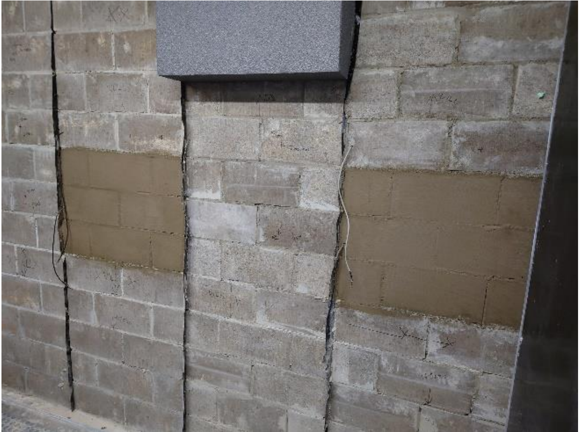
Joonis 11. Hüdroisolatsiooni ribad villavööde taga peale paigaldust
