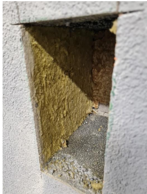
Joonis 22. Seina avamisel oli näha villavöös värvitooni muutust (vasakul) ning jääkristalle villa poorides.
