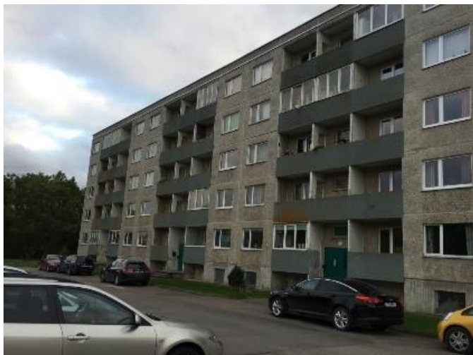
Joonis 2. Renoveerimata näidismaja
