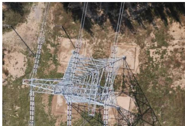
Joonis 1.22. UAV poolt salvestatud pilt kõrgepingeliinimastist [12]
