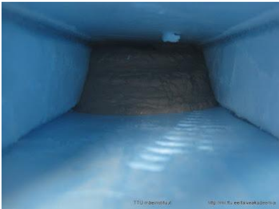
Joonis 26-6 Käigu täitumine täiteseguga
