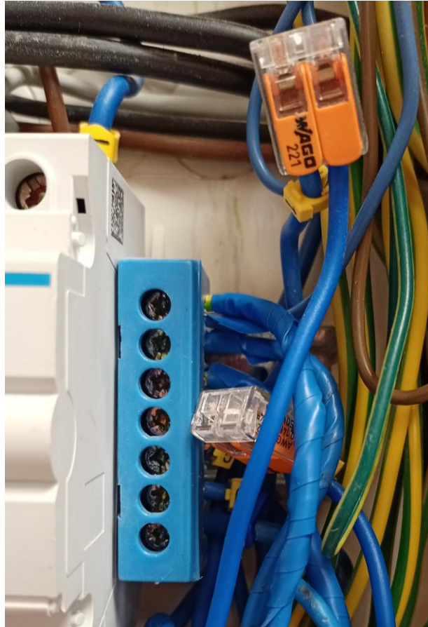
Joonis 2.15 Vattmeetrite ühendamine nullklemmiga
