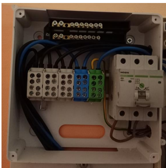
Joonis 2.10 Ühendamine vana toitesüsteemiga
