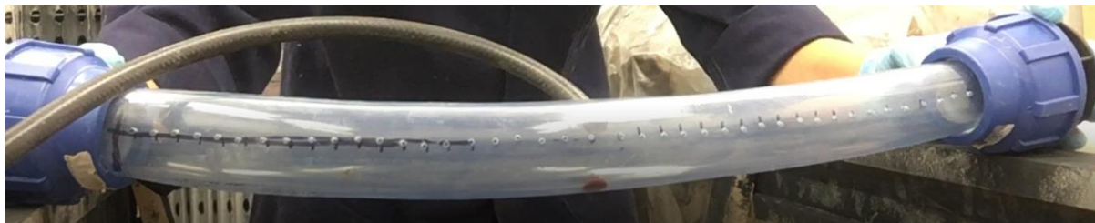
Sele 6.6. Väljavoolu avade keeramine liimi sissevoolamisel
