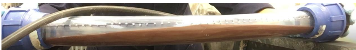
Sele 6.7. Liim täidab pool toru, enne kui liimitusavad õigesse asendisse keeratakse.
