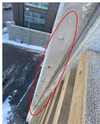
Joonis 4.26 Armatuuri kaitsekihi puudumine paneeli koorikukihil [autori foto]
