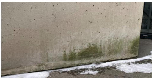
Joonis 4.5 Soklipiirkonna sammaldumine põhjasuunas [autori foto]
