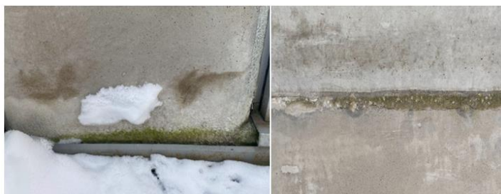
Joonis 4.30 Sammaldumine soklijoone piirkonnas [autori foto]
