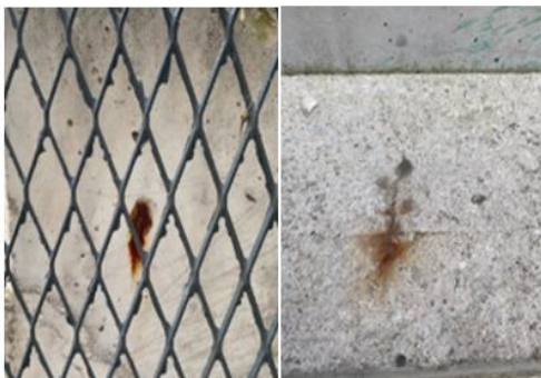
Joonis 4.41 Armatuuri roostetamine välistrepil [autori foto]
