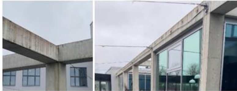
Joonis 4.44 Katusejoone bioloogilise kasvu ja õhusaaste ilmingud [autori foto]
