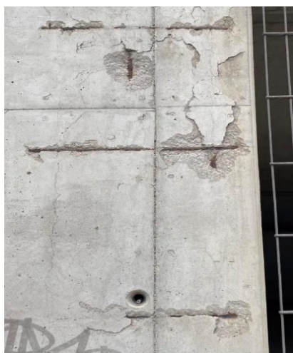
Joonis 2.3 Kahjustus mittepiisava kaitsekihi tõttu Toompuiestee 33a parkimismaja välipinnal [autori foto]
