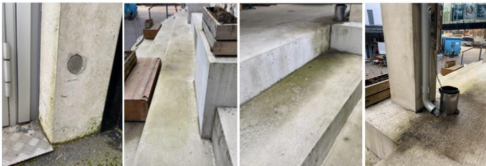
Joonis 4.40 Vetikate koloniseerimine soklijoone piirkonnas [autori foto]
