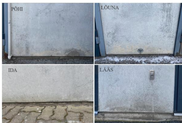
Joonis 4.24 Soklijoone kahjustused peailmakaarte suhtes [autori foto]
