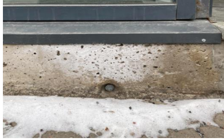
Joonis 2.7 Jäitevastaste soolade ladestumine betoonpinnale [autori foto]
