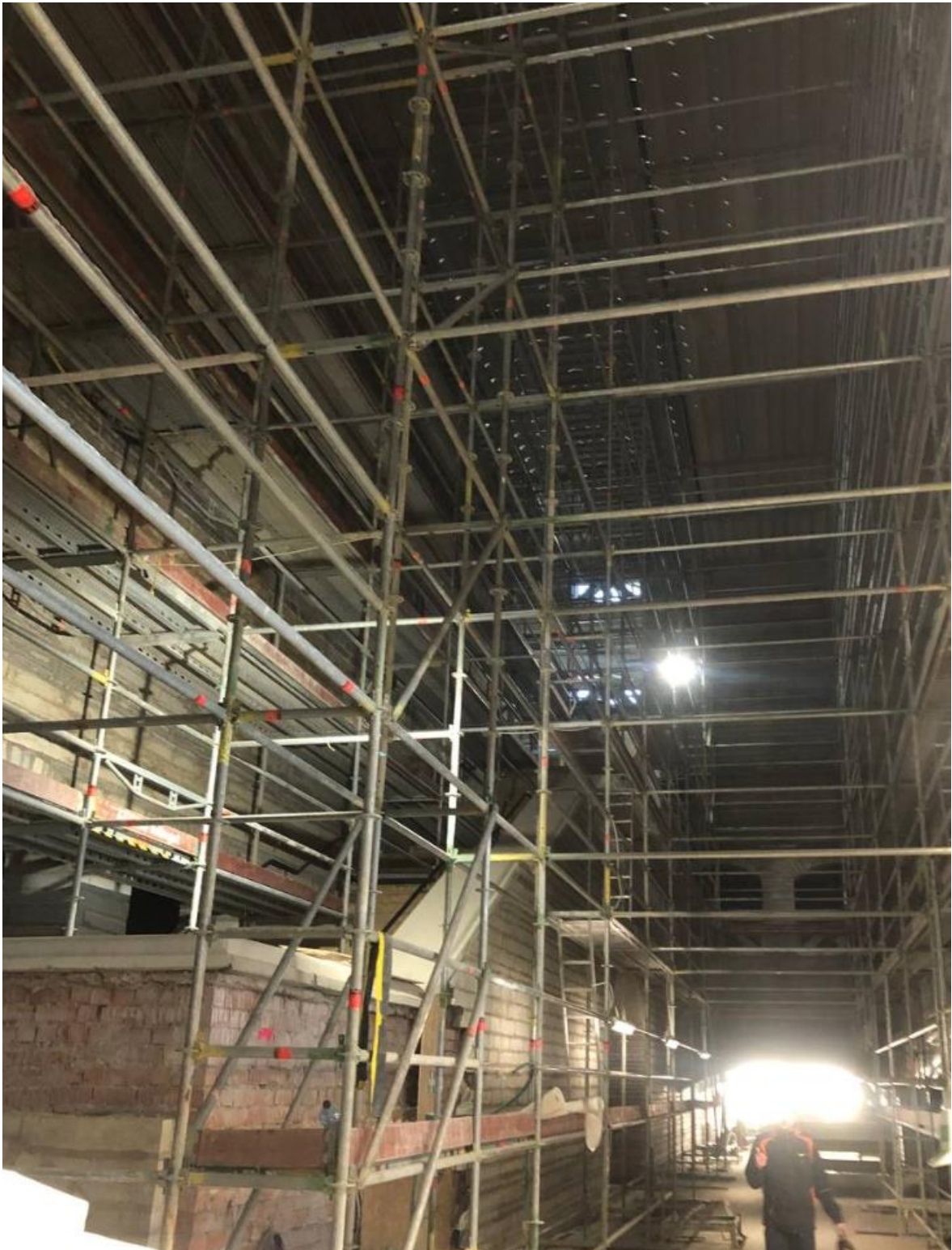
Lisa 4 Fuajees laealuste tööde teostamiseks paigaldatud tellingud [Autori foto]
