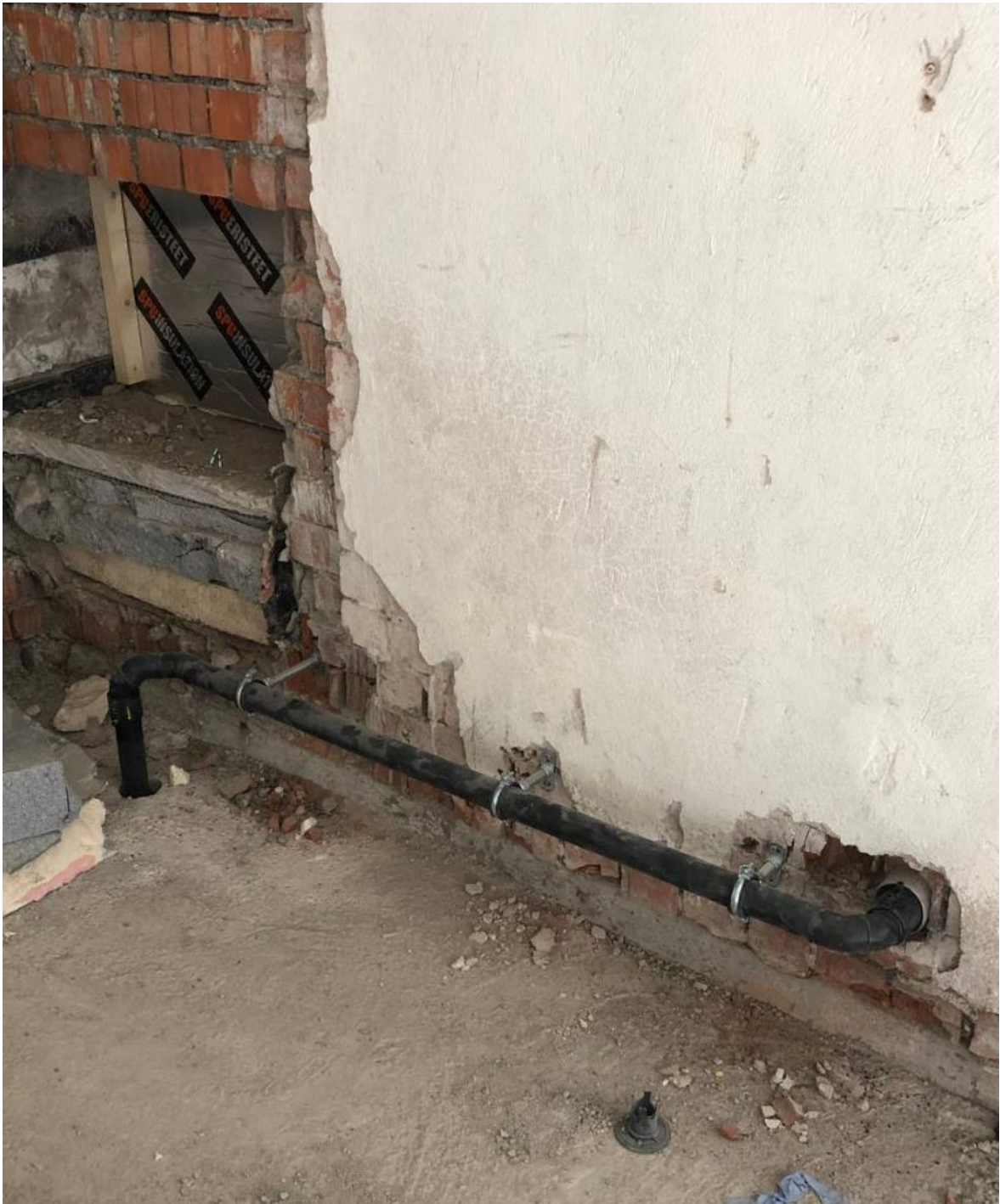
Lisa 2 Sademevee äravoolu Geberit Pluvia vaakumtorustik katuselt tornis [Autori foto]
