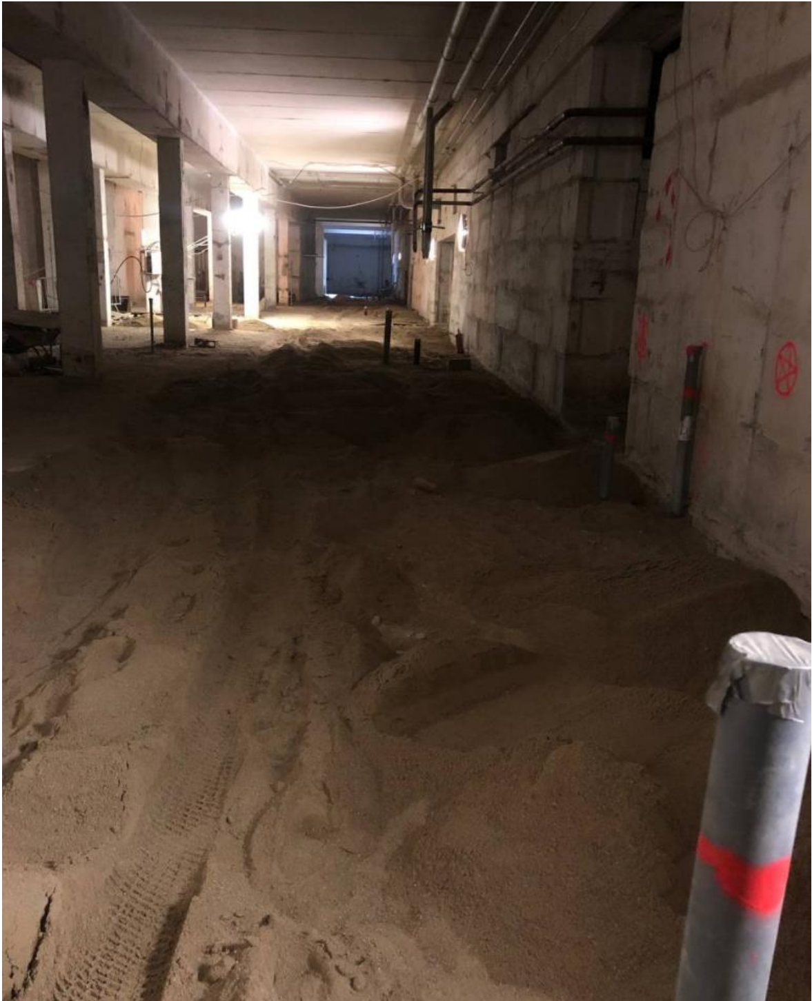
Lisa 7 Sademevee- ja kanalisatsiooni torustik paigaldatakse otse pinnasesse [Autori foto]
