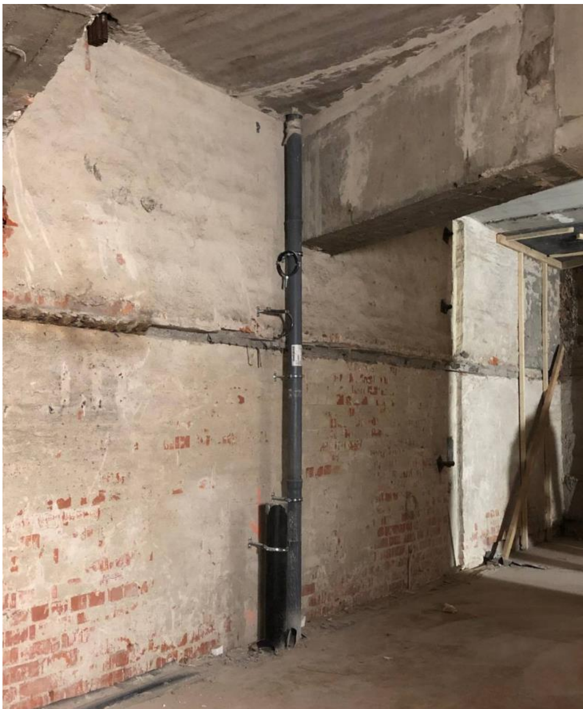
Lisa 8 Kanalisatsiooni püstik ja sademevee püstiku valmidus külmas hoidlas, millele hiljem paigaldatakse veetihe sein lekkeanduriga [Autori foto]
