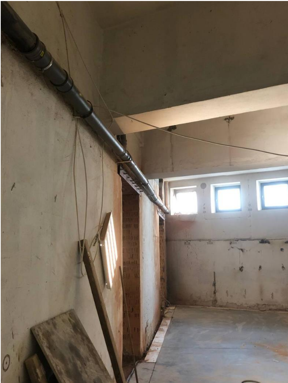
Lisa 9 Laealune kanalisatsiooni magistraal külmas hoidlas, millele hiljem paigaldatakse veetihe ripplagi lekkeanduriga [Autori foto]
