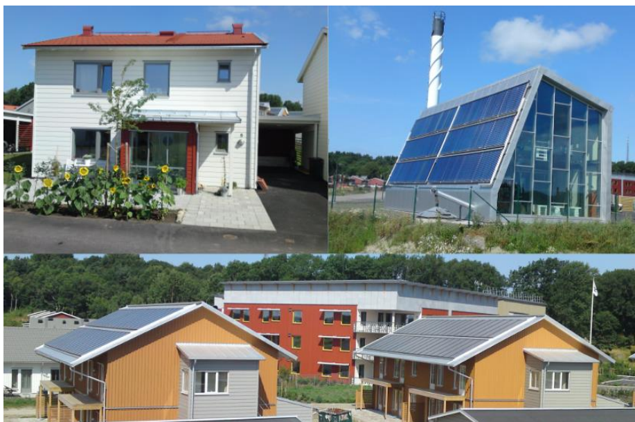
Joonis 1.9 Vallda Hebergi lameplaatkollektoritega eluhooned ja vaakumtorudega päikesekollektoritega katlamaja [27]
