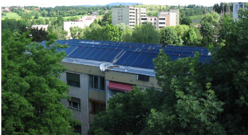
Joonis 1.10 Lameplaatkollektoritega hoone Berlinerringi elamukompleksis [28]
