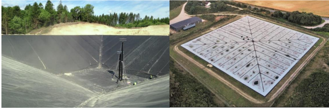
Joonis 1.16 Dronninglundi hooajaline süvendsoojussalvesti konstruktsioon ja töös oleva salvesti pealtvaade [37]
