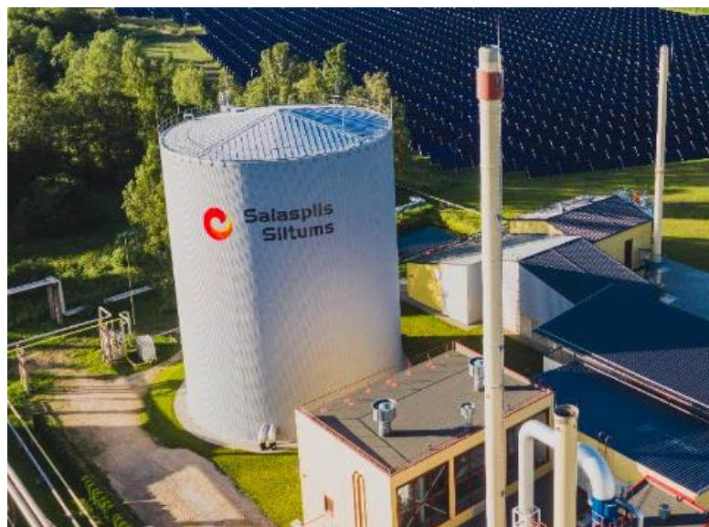
Joonis 1.14 SIA Salaspils Siltums lühiajaline soojussalvesti, katlamaja ja päikesepark [34]
