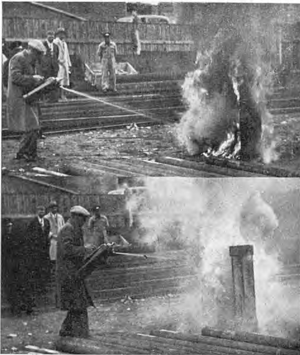
Moodsad tulekustutajad tegevuses (ülal): tõrvaga ja petrooleumiga ülekallatud ning heinte ja laastudega täidetud kast põleb. Juhtides „Quouquest'ist“ tuldkustutava vedeliku joo tulele, on välditud hädaoht ja tuli summutatud lühikese aja
