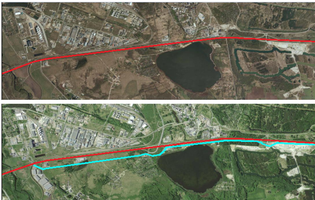
Joonis 1.3 riigitee nr 1 Loo-Maardu teelõigu (km 10,6-17,4) võrdlus aasta 2007 (üleval) ja aasta 2018 (all)[7] (Autori poolt kohandatud)
