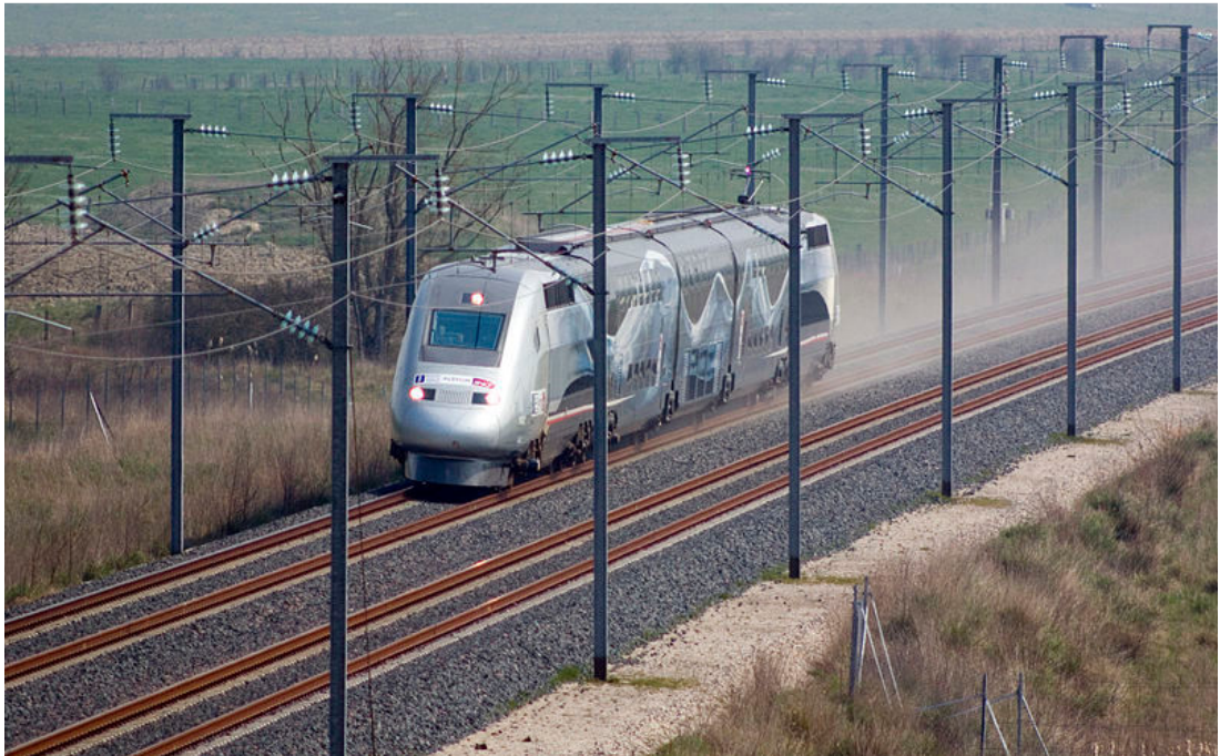
Joonis 1.14 Maailmas kiireim elektriraudteerong (574,8 km/h) TGV, Prantsusmaa 2007 a.
