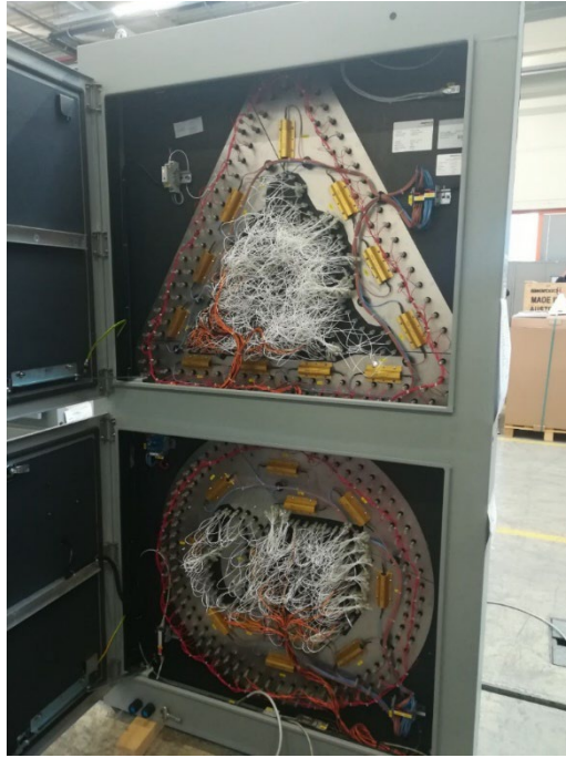
Joonis 4.4 Termotakistitega varustatud VMS [4]
