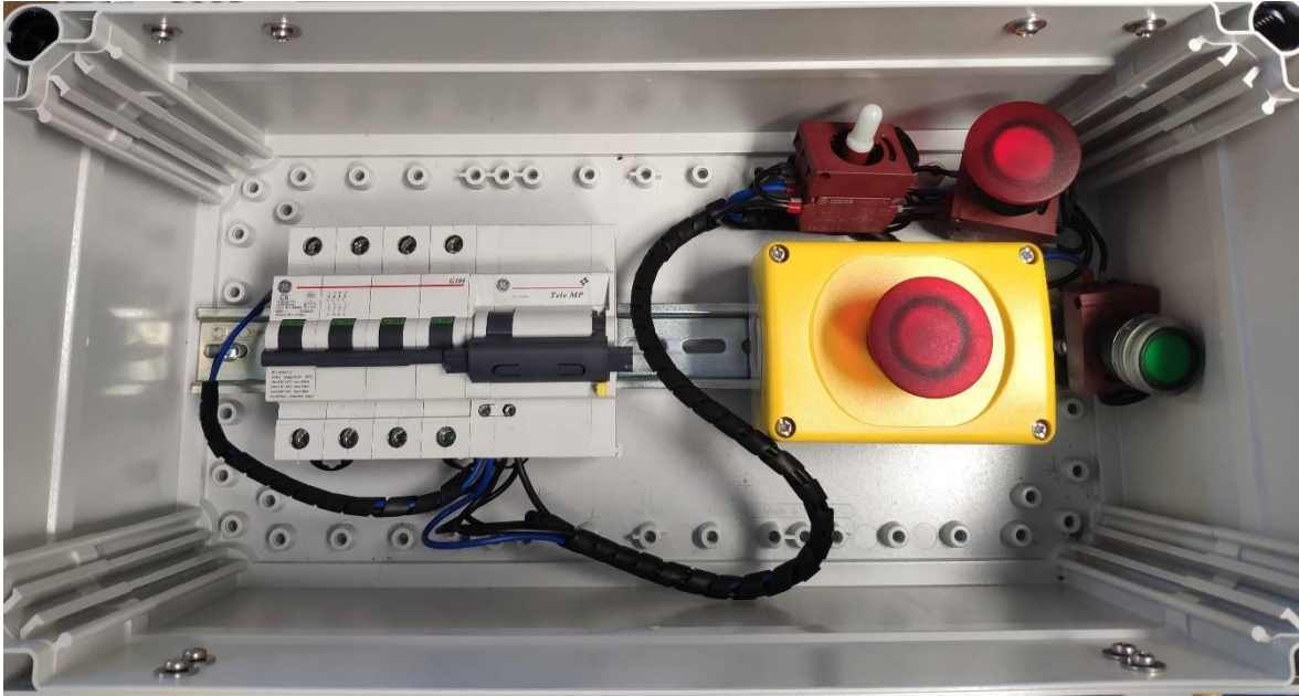
Joonis 4.7 Motoriseeritud lüliti koos kaitselülitiga ning sisse- ja välja lülitamiseks mõeldud lülititega
