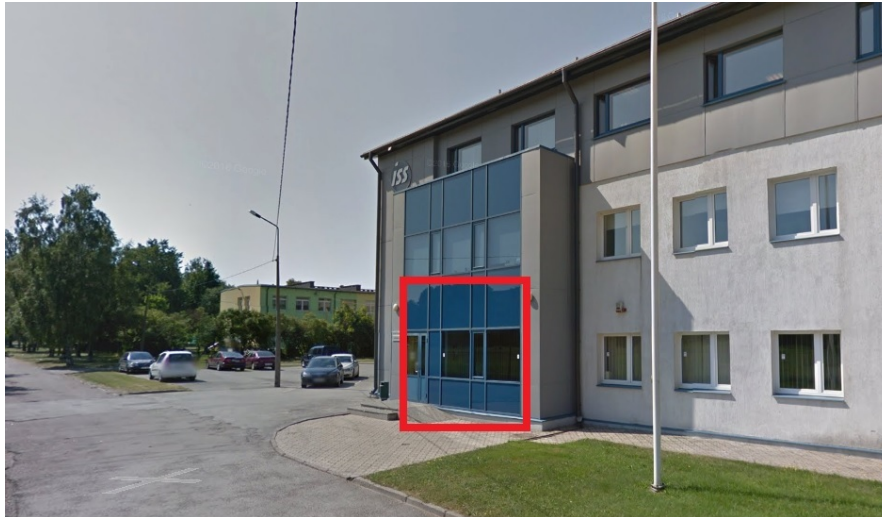
Joonis 14. Sensori 7 (Vilde tee 129) hoone väljast
