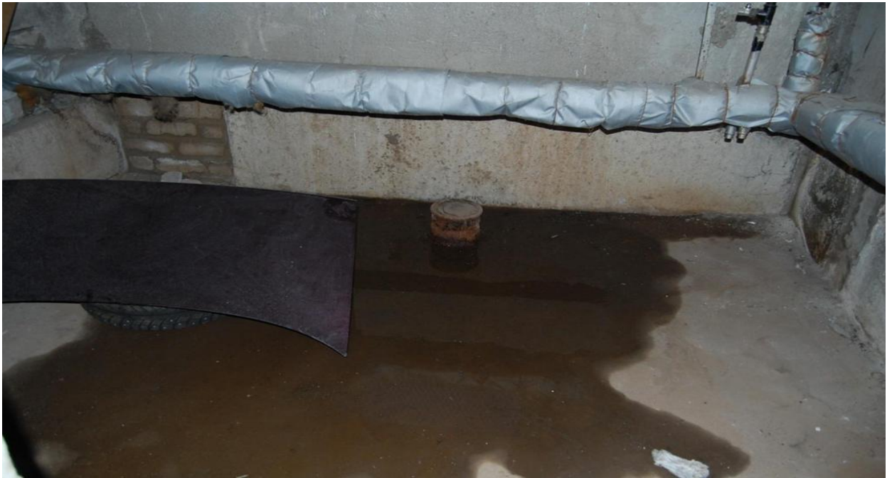
Фото №3. В фото показано, что фундамент местами разломлен, вследствие этого в подвале образуются лужи.
