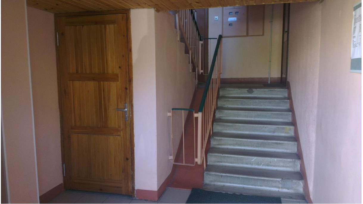
Фото №8. Как снаружи, так и внутри были сделаны ремонтные работы.
