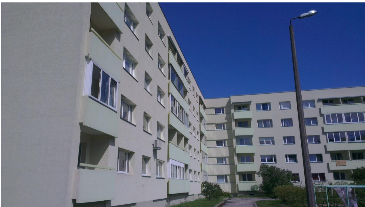
Фото №7. Фасад дома полностью приведён в порядок.
