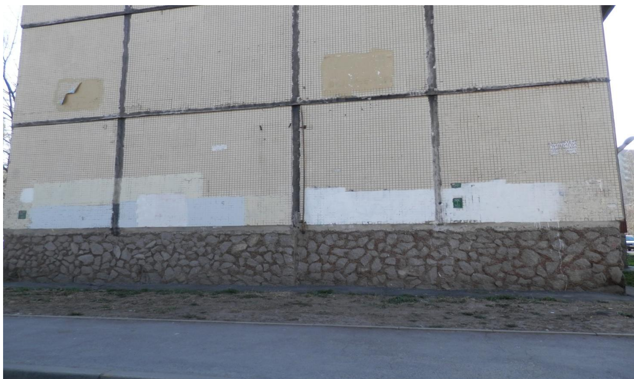
Фото №10. Стены дома не утеплены. Стыки замазаны, но не понятно с каким качеством это было сделано.
