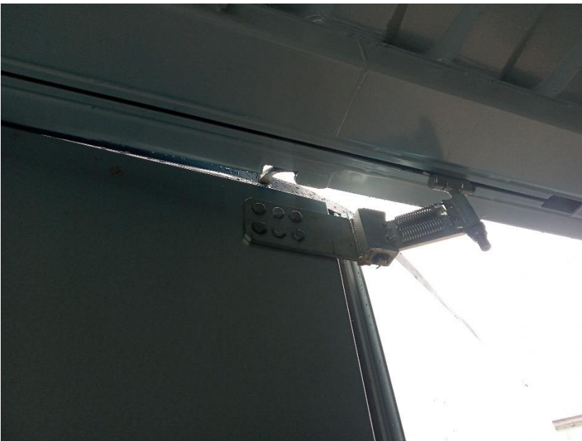
Joonis 7. Juhik ja rull konteineri laes
