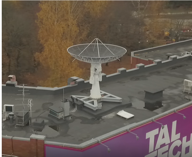
Joonis 6: Maajaama antenn Mekotry katusel.
